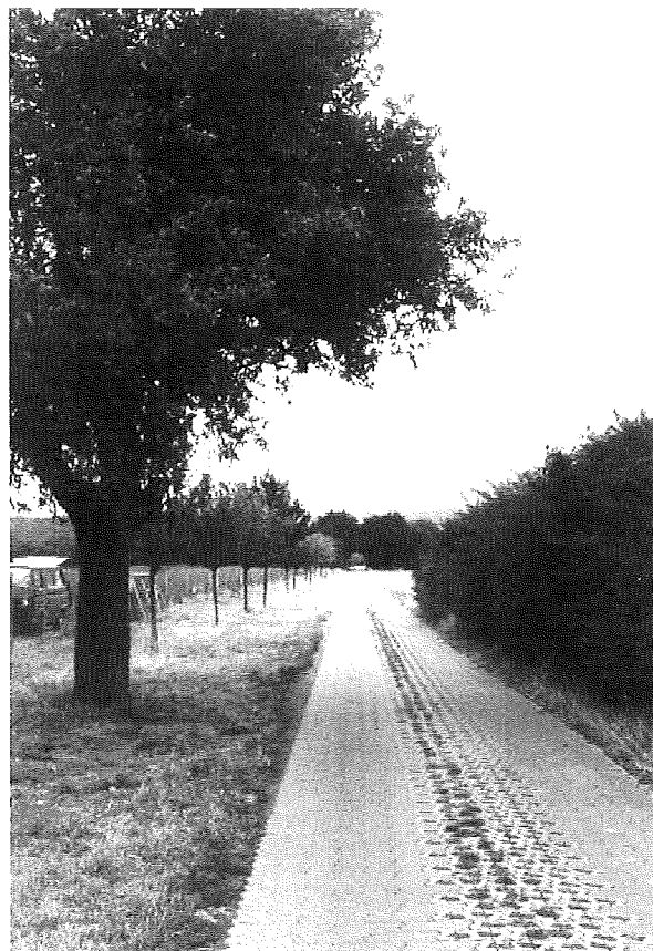
Abb. 2: Neu gebauter Spurbahnweg mit begleitender Baumreihe
