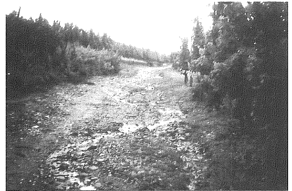
Abb. 28: Wegeschäden durch Verhinderung des talseitigen Wasserabflusses
