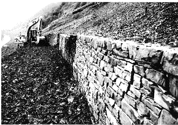
Abb. 5: Sanierte Mauer und angelegte obere Terrasse
