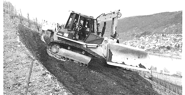
Abb. 4: Neuanlage von Querterrassen im Nachbarverfahren Koblenz Moselweiß
