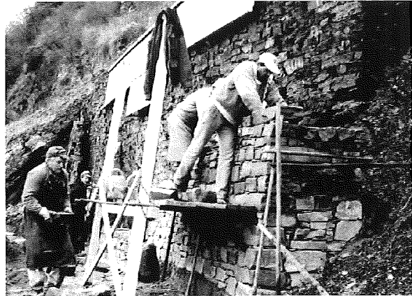
Abb. 3: Sanierung von Trockenmauern in Handarbeit
