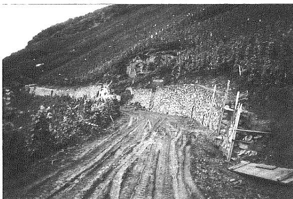
Abb. 32: Natursteinmauer mit Betonvermörtelung
