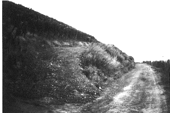
Abb. 24: Neuanlage eines Wendeweges auf vorhandener Böschung
