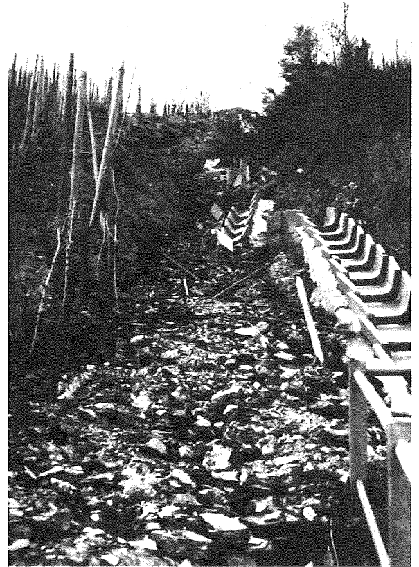
Abb. 21: Erosionsschäden aufgrund fehlender Unterhaltung
