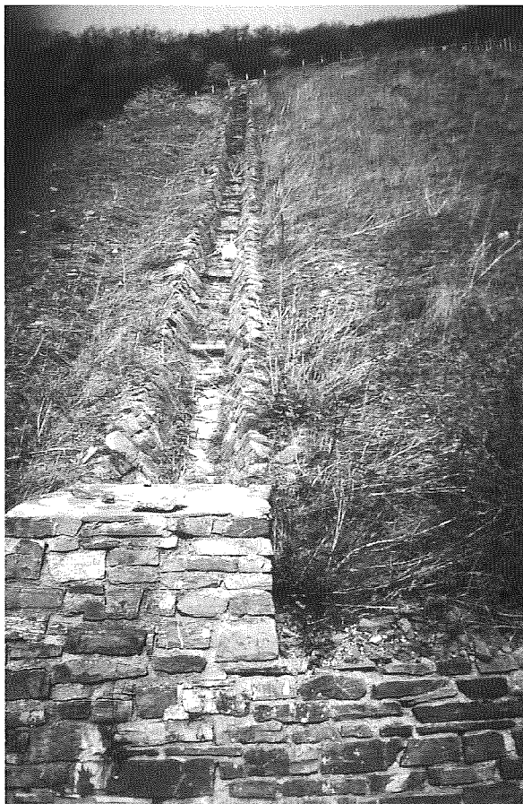
Abb. 38: Naturnäherer Gewässerbau mit Steinstickungen
