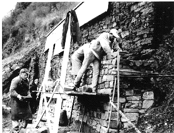
Abb. 4: Mauersanierung in Trockenbauweise
