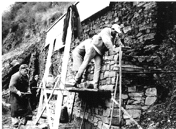
Abb. 3: Sanierung von Trockenmauern in Handarbeit
