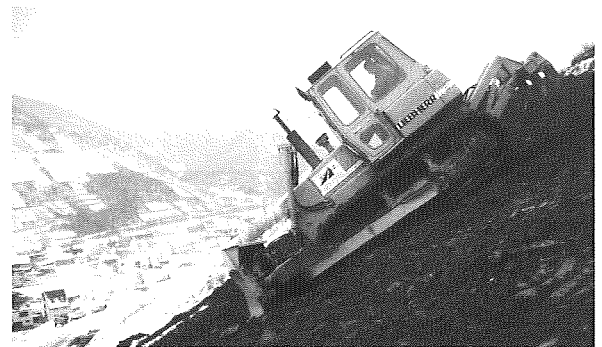
Abb. 29: Raupeneinsatz in großflächiger Planierung
