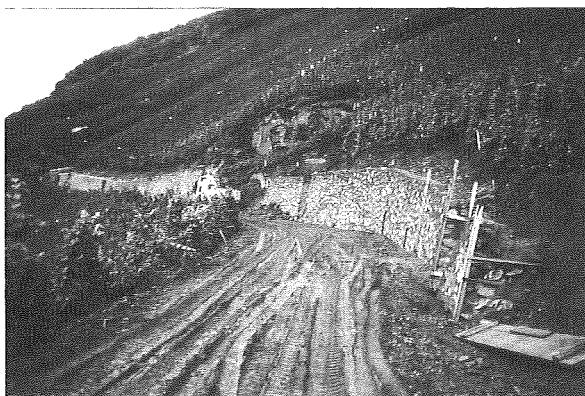
Abb. 32: Natursteinmauer mit Betonvermörtelung
