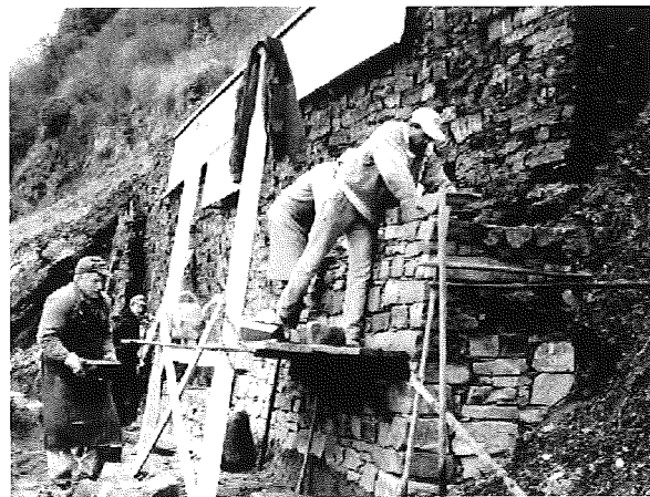
Abb. 4: Mauersanierung in Trockenbauweise
