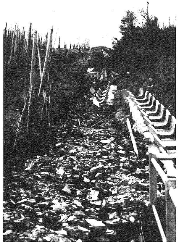
Abb. 21: Erosionsschäden aufgrund fehlender Unterhaltung
