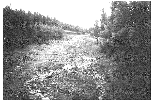
Abb. 28: Wegeschäden durch Verhinderung des talseitigen Wasserabflusses
