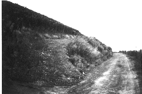
Abb. 24: Neuanlage eines Wendeweges auf vorhandener Böschung
