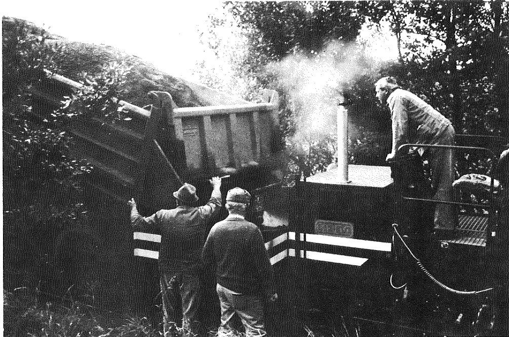
Bild 4: OLM-Straßenfertiger beim Beladen mit Mischgut vom LKW
