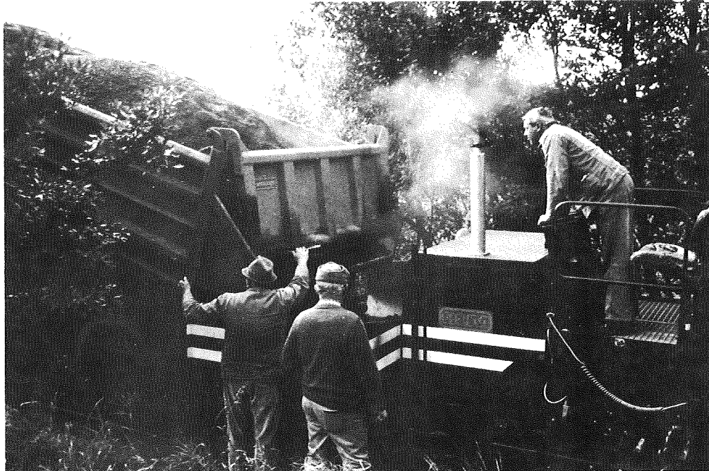
Bild 4: OLM-Straßenfertiger beim Beladen mit Mischgut vom LKW
