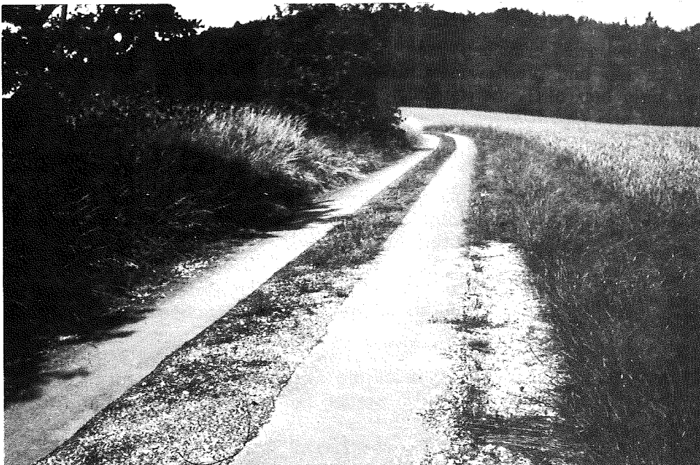
Bild 8: Festigkeit und Begrünung der Rand- und Mittelstreifen. Im Vordergrund deutlich erkennbar spärlicher Bewuchs auf beinahe sterilen Porphyrböden, anschließend dichter Bewuchs auf Diabas.
