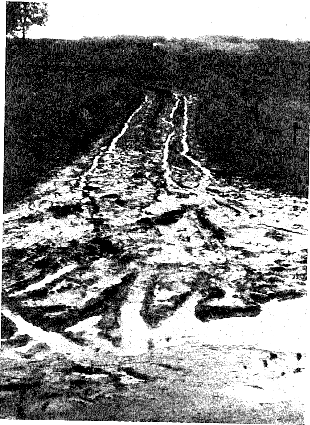
Bild 26 — Unzulänglicher Wegebau
