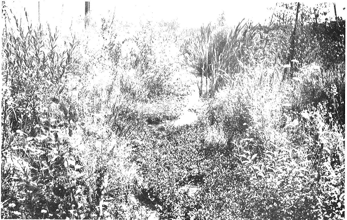
Abb. 5: Ausbau. Kurz nach der Fertigstellung. Unregelmäßiger Querschnitt bei erhöhter Wasserführung; steilere und flache Böschungen wechseln ab, Querschnittsaufweitung mit Ablagerungen, einzelne große Natursteine am Böschungsfuß. Möglichkeit gewisser Hochwasserrückhaltung. Sehr gelungene Gestaltung.
