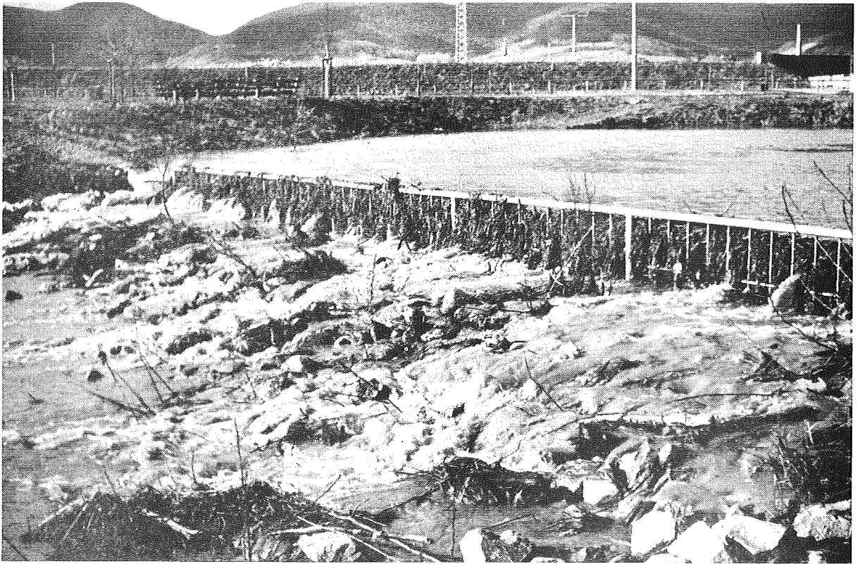
Abb. 9: Rückhaltebecken mit Vorrechen
