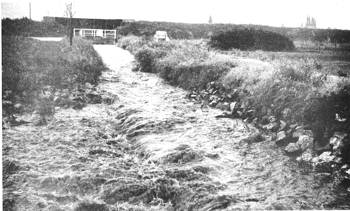
Abb. 8: Bach wird bei Hochwasser über eine Schwelle zum Vorbecken entlastet. Der Bach führt - wie erwartet - erhebliche Mengen Schlamm und Sand mit.
