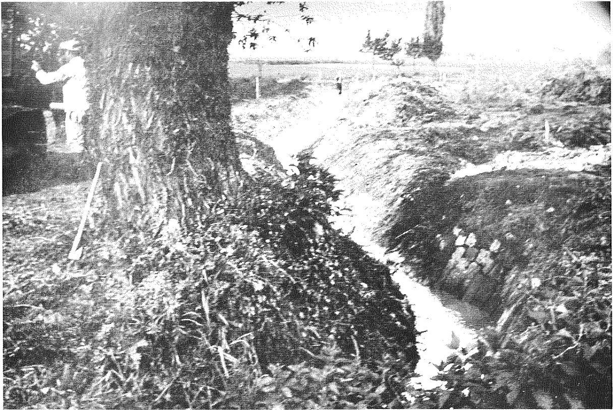
Abb. 3: Geschwungene Linienführung, Erhaltung des bestehenden Bestandes, wechselnde Böschungsneigungen, keine unangemessene Sicherung des Gewässerbettes.
