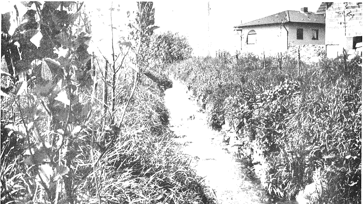
Abb. 4: Im Entwicklungsstadium; unregelmäßig gestaltete Böschungen, kleine Schwellen im Sohlbereich, wechselnde Querschnitte und leicht geschwungene Linienführung. Gelungene Ausführung!
