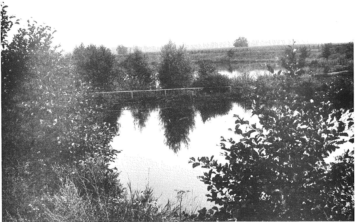
Abb. 7: Schlamm- und Sandfang. Dauerstau verdeckt Ablagerungen, die nur in größeren Abständen ausgeräumt werden müssen. Im Hintergrund Überlauf mit niedrigem Rechen zum Hauptbecken.
