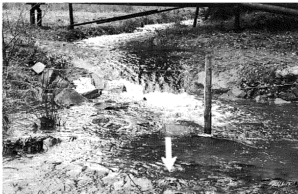
Abb. 5: Abschnitt 25 - Gepflasterte Furt mit Sohlabsturz
