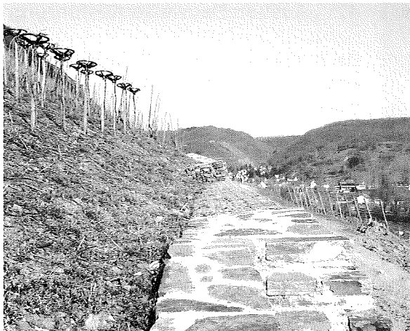
Abb. 2: Erosionsbremse durch Freihalten der Mauerkrone
