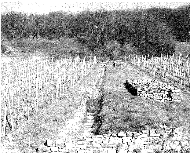
Abb. 5: Gewässerausbau: Kaskaden und Geröllsperre
