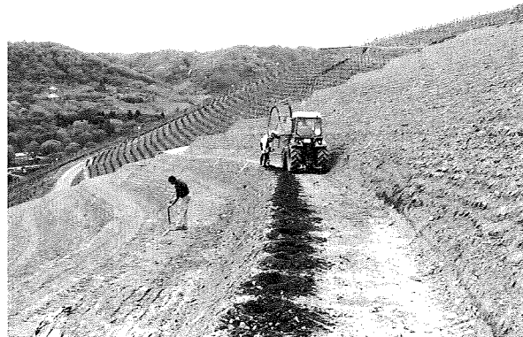
Abb. 18: Herstellung der Pflanzlöcher
