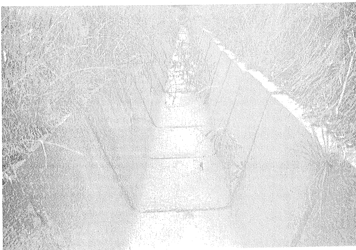
Abbildung 5: Trapezschanen stellen für zahlreiche Tierarten eine unüberwindliche Barriere dar und sollten nicht mehr verwendet werden.
