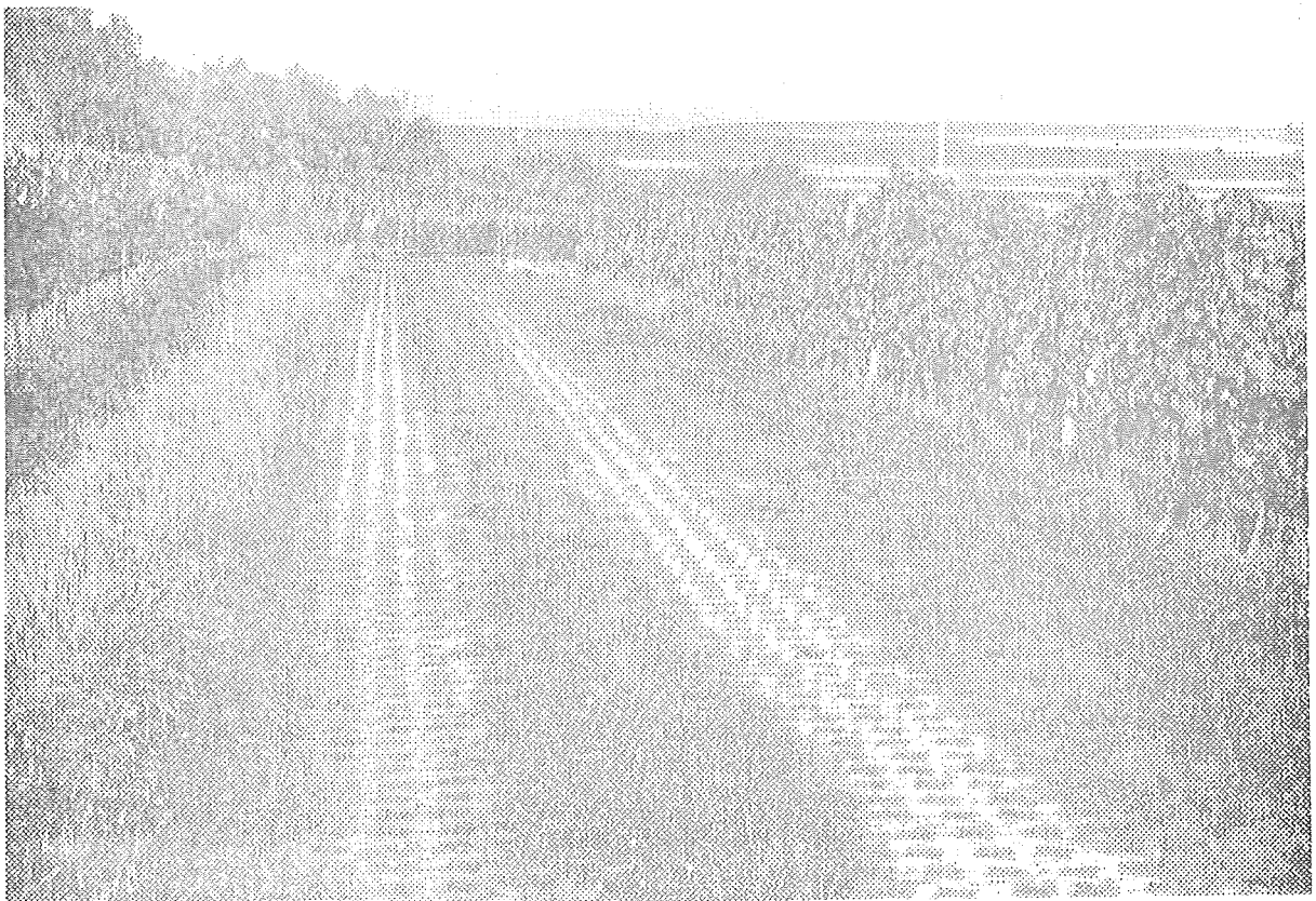
Abbildung 2: Mit Rasenverbundsteinpflaster ausgebauter Wirtschaftsweg in einem Weinbergshang (Flurbereinigungsverfahren Bornheim - Landkreis Alzey-Worms)
