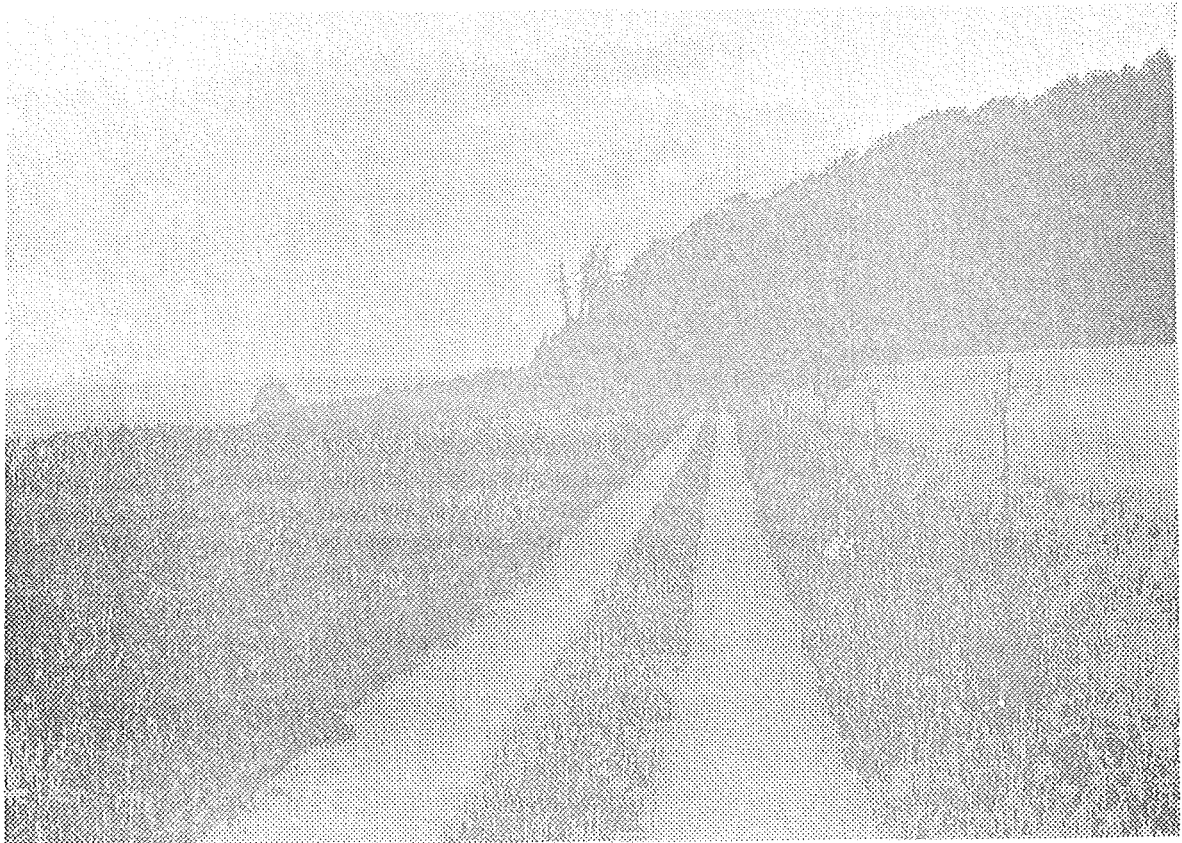
Abbildung 1: Mit Bitumenspurbahnen ausgebauter Wirtschaftsweg, der auch als Wanderweg häufig frequentiert wird (Flurbereinigungsverfahren Becheln - (Rhein-Lahn-Kreis))
