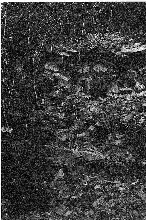
Abb. 10: Eingefallene Trockenmauer
