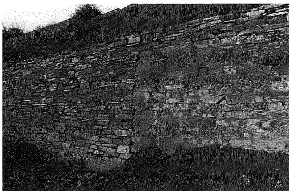
Abb. 12: Sanierte Trockenmauer
