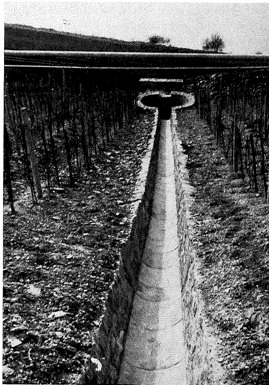
Abb. 2: Weinbergbereinigung Stetten — Wasserabschlag mit Schlammfang
