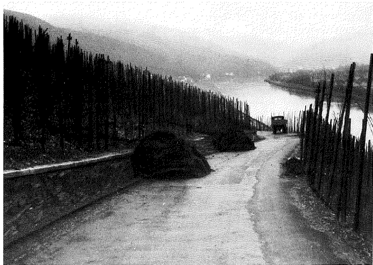
Abb. 20 Unterirdische Wasserabführung in Wehlen Saubere, aber kostspielig
