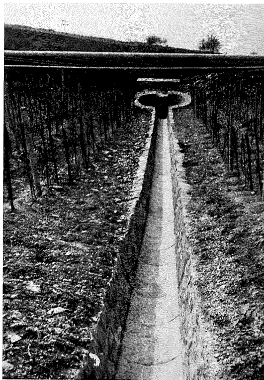
Abb. 2: Weinbergbereinigung Stetten — Wasserabschlag mit Schlammfang
