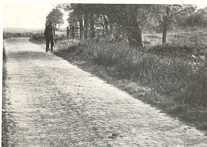
Bild 15: Moorriem: Alte Pflasterbefestigung aus Klinker. Der schwer gewordene Verkehr hat tiefe Verdrückungen hinter- lassen.
