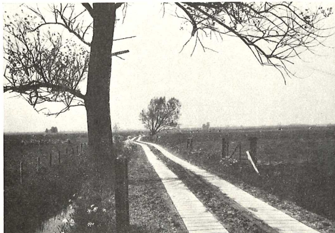
Bild 19: Flurbereinigung Moor- riem. Beispiel einer leichten Wegebefesti- gung der Spurbahnen mit Betonverbund- steinplatten.
