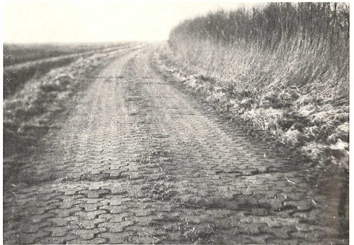
Bild 18: Flurber. Moorriem, Oberhörner Hellmer Verlängerung. Auf Kalkverfestigung Wardenberger Ver- bundpflasterstein- decke. Wühlmäuse haben die sonst gut liegende Decke be- schädigt. (phot. Schmidt)
