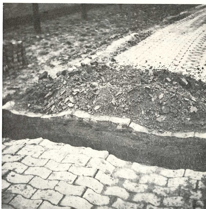
Bild 16: Flurber. Moorriem: Hohfeldsmittelweg. Die kalkverfestigte Schicht macht die durch schweren Verkehr hervorgerufe- nen Verdrückungen des Untergrundes mit. (phot. Schmidt)
