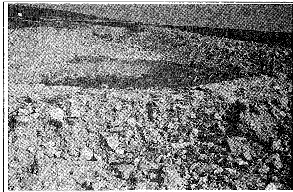
Ein wichtiges Renaturierungsziel bestand darin, der Selz mehr Raum zu geben, damit sie aus dem engen, eingetieften alten Bachbett heraustreten kann. Hierzu wurden an verschiedenen Stellen Uferabflachungen vorgenommen.
