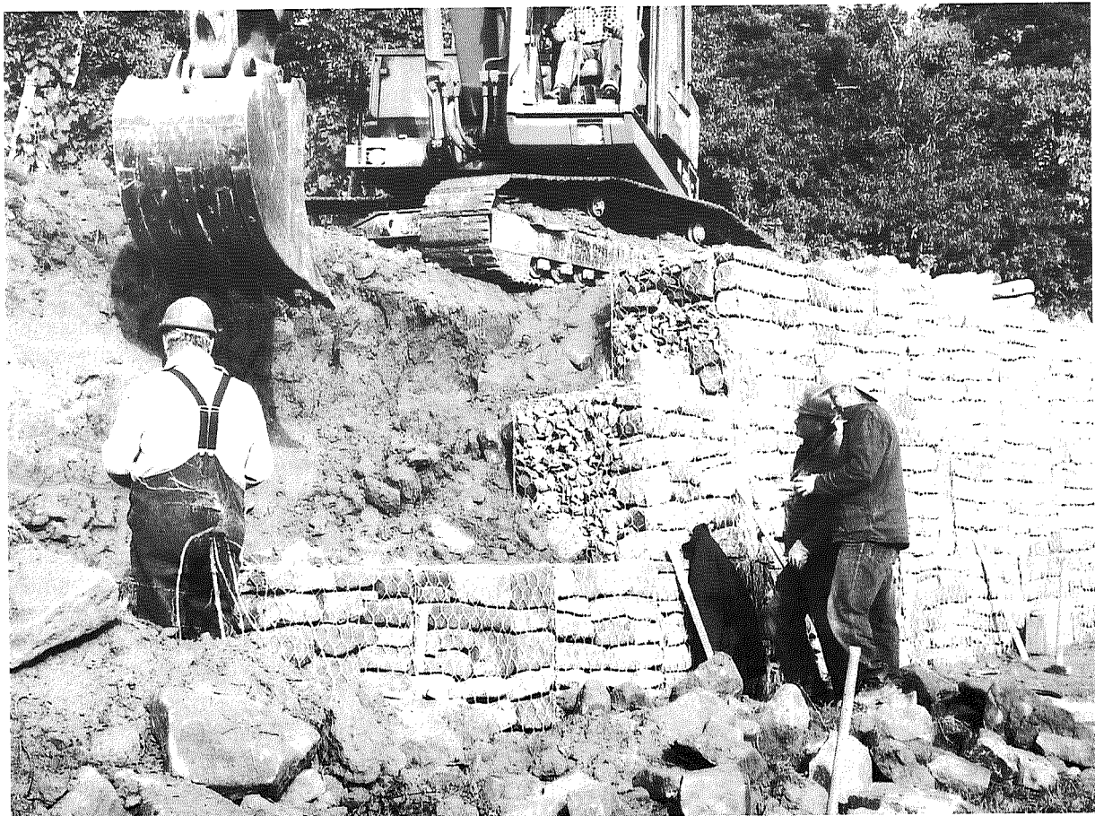
Abb. 2: Herstellung einer Gabionenwand in Deidesheim am Kirchberg
