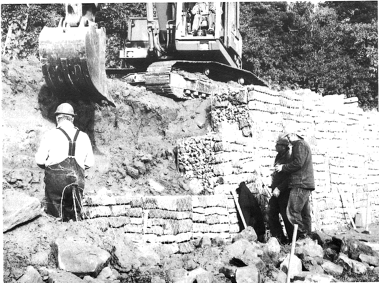
Abb. 2: Herstellung einer Gabionenwand in Deidesheim am Kirchberg
