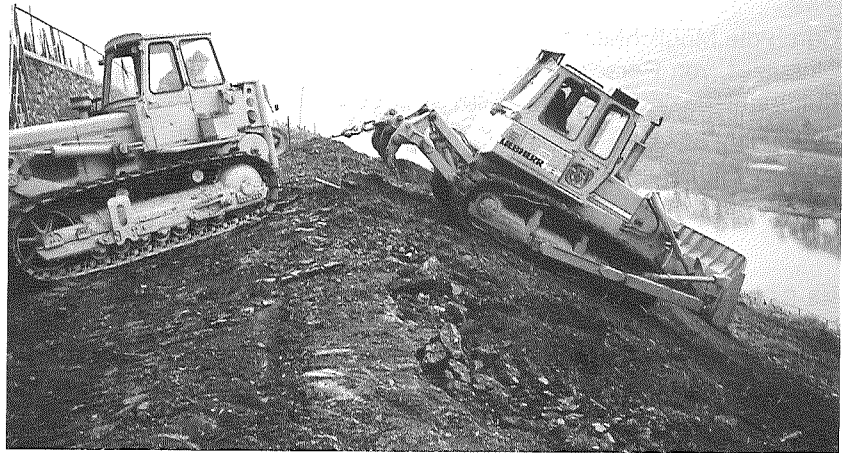
Abb. 1: Planierdraupe am Seilzug an der Mittelmosel bei 60% Hangneigung
