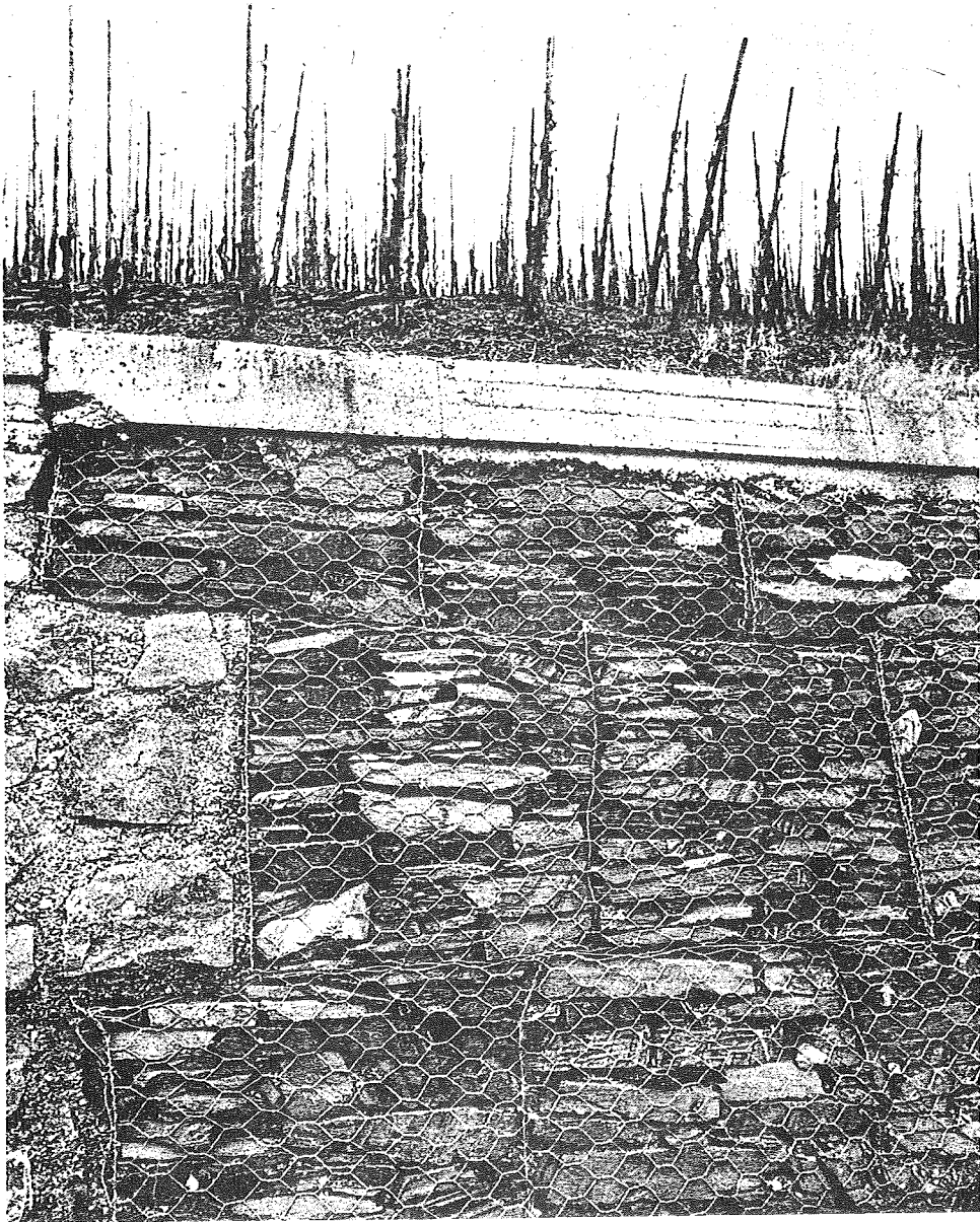
Drahtgitterkörbe verleihen den Stützmauern zusätzlichen Halt.
