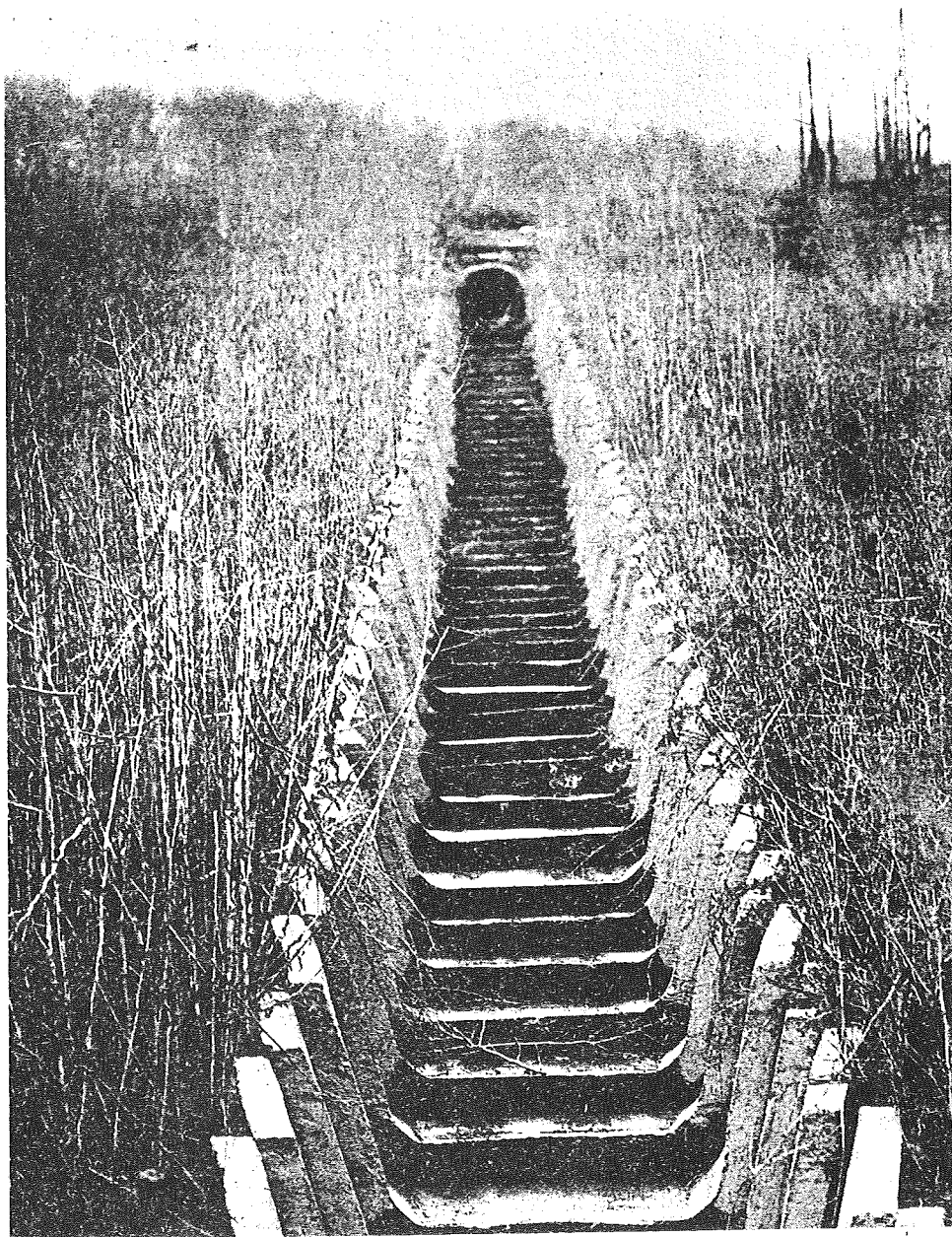
Zur schadlosen Ableitung des Oberflächenwassers werden Doppel-Trapezschalen in flurbereinigten Weinbergen eingebaut. Sie sorgen für einen verlangsamten Fluß des Wassers.
