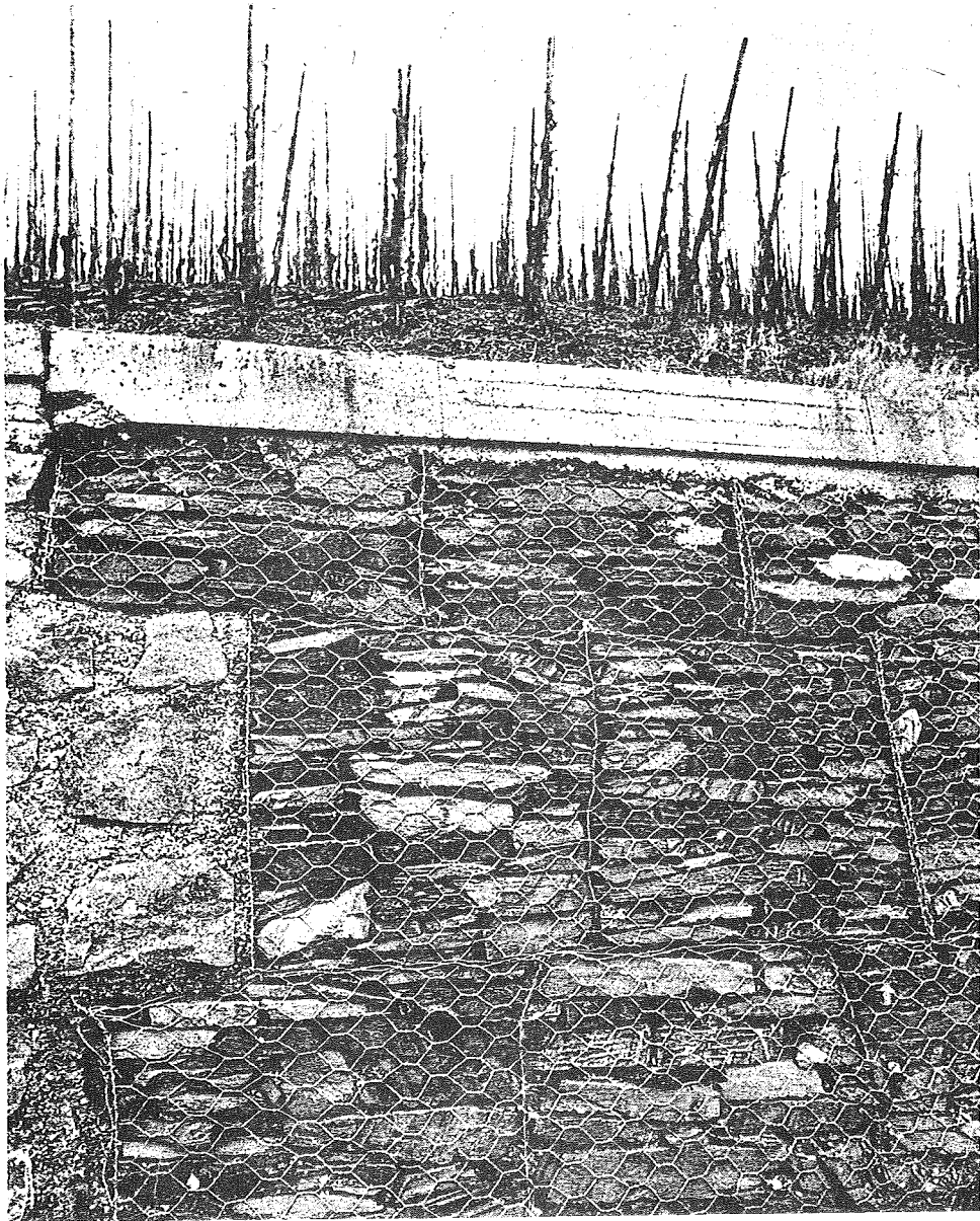
Drahtgitterkörbe verleihen den Stützmauern zusätzlichen Halt.
