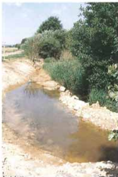
Abb. 6: Renaturierung mit Stillwasserzone im Seitenschluß unmittelbar nach dem Ausbau
