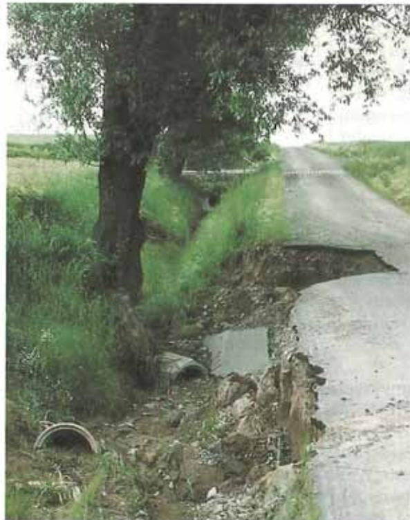
Abb. 4: Wassererosion kann erhebliche Schäden verursachen
