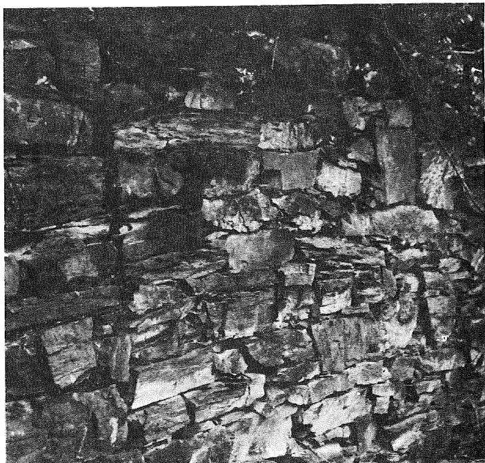
Bild 1: unverfugte, alte Trockenmauer (Disselhoff)
