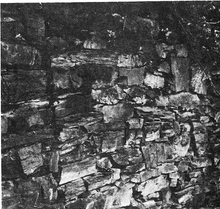
Bild 1: unverfugte, alte Trockenmauer (Disselhoff)
