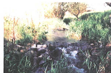
Sohlenhebung durch Einbau von Sohlrampen
