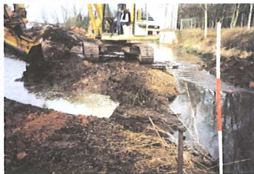
Bauphase (Februar 1998) Anschluß eines Altarms
