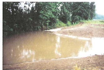
Nach Profilierung der neuen Gewässer und Mulden geringer Anstau des Wiesbaches zwecks Flutung der Aue
