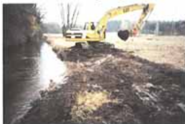
Bauphase (Februar 1998) Abflachen der Uferböschung zur Stärkung der Eigendynamik
