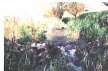
Schlanhebung durch Einbau von Sohlrampen
