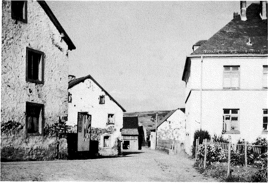
Abb. 29 Flurbereinigung Berk, Kreis Schleiden Die Landstraße ist auch im weiteren Verlauf zu schmal und unübersichtlich.
