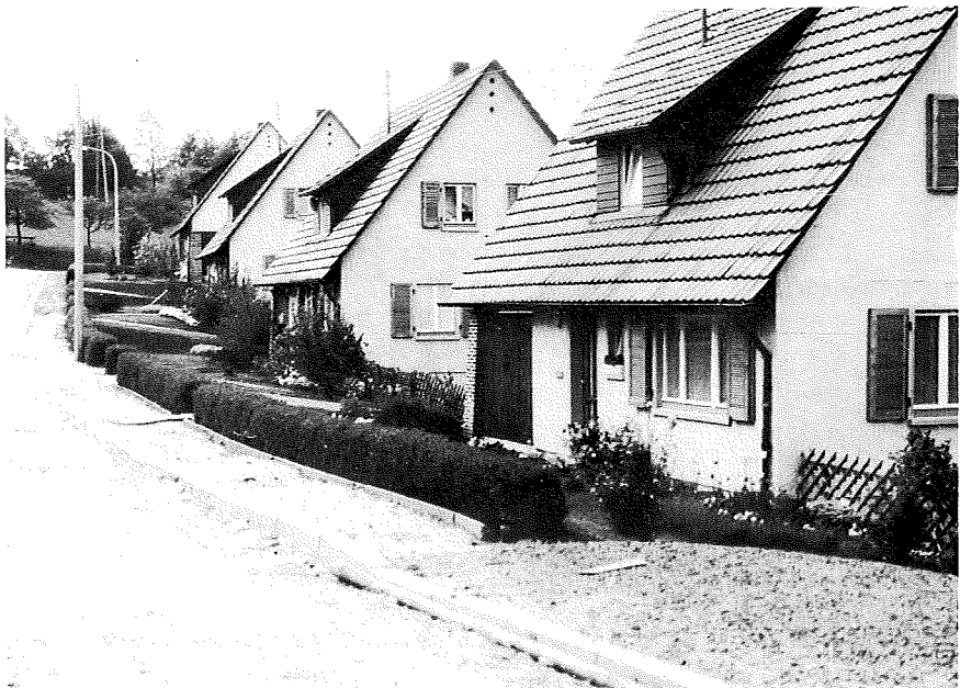
Abb. 44 Flurbereinigung Merchingen, Kreis Buchen Neue Wohnstraße am Ostrand des Ortes.
