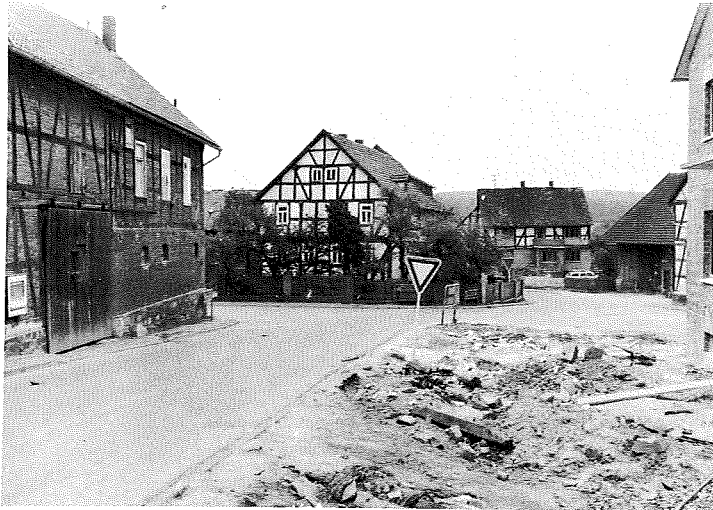
Abb. 35 Flurbereinigung Willinghausen, Kreis Ziegenhain
