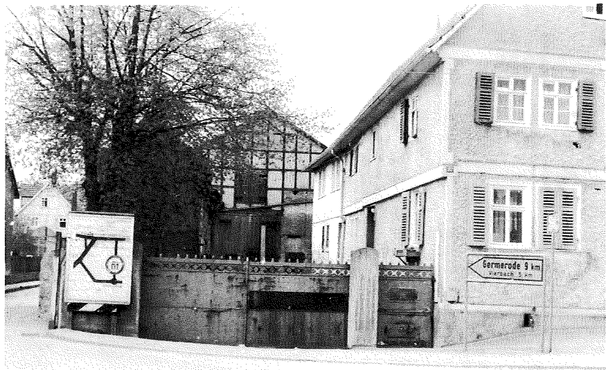
Abb. 40 Flurbereinigung Reichensachsen, Kreis Eschwege Nach dem Abbruch des hinter den Bäumen versteckten Gehöftes eines Aussiedlers im Zuge der 1961 eingeleiteten Flurbereinigung wird die bisher zu enge Straßeneinmündung breit und übersichtlich.
