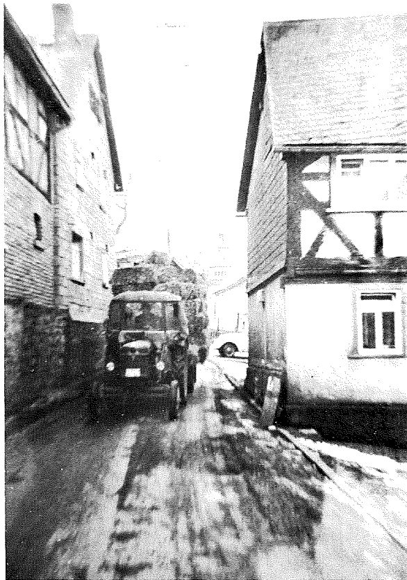
Abb. 37 Engpaß in einer Ortsstraße von Beilstein, Dillkreis Das Wohnhaus eines der drei in der Flurbereinigung ausgesiedelten Betriebe versperrt die Straße.
