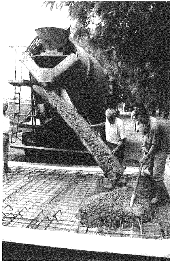
Abb. 10: Betonieren der Brückenplatte auf die endgültige Plattendicke
