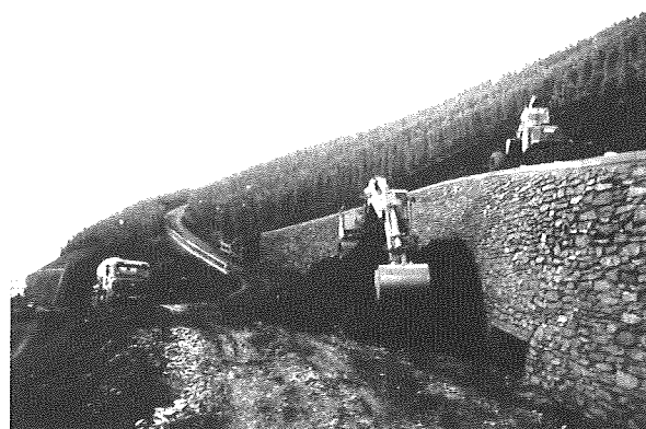
Abb. 14: Arbeiten durch Unternehmer an den Hinterfüllungen der Weinbergsmauern. Durch sinnvolle Koordination konnten Behinderungen untereinander ausgeschlossen werden
