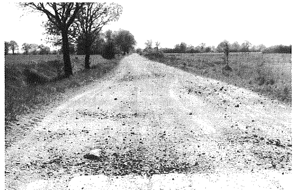
Abb. 2: Wassergebundene Decke mit Schäden
