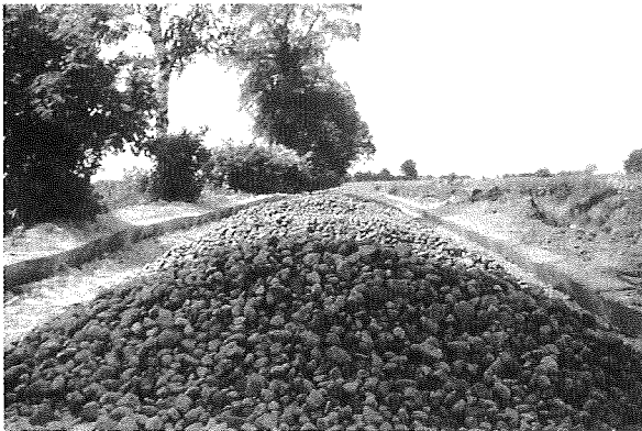
Abb. 1a: Sandgeschlämmte Sammelsteintragschicht mit Randbefestigung aus Betonbahnschwellen; Bauphase und nach ca. 12 Jahren Nutzung
