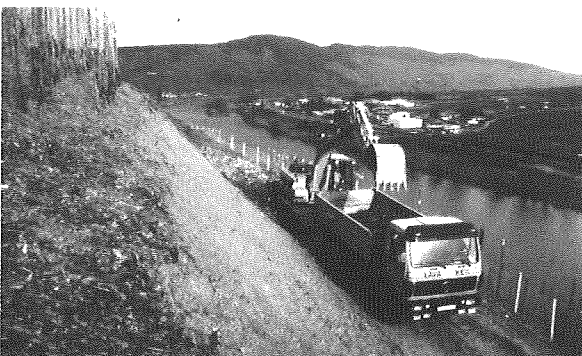
Abb. 13: Herstellen der Wegetrasse 104 durch VTG Bagger und Firmen - LKW. Aufgrund der extremen Hangneigung bedarf es des Einsatzes von erfahrenen Maschinenführern
