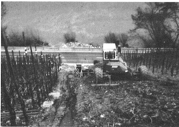
Abb. 12: Nachdem der Durchlaß durch die B 53 fertiggestellt war, konnte das Gewässer 410 mittels steilhangfähigem Schreitbagger bei 50% Hangneigung hergestellt werden.
