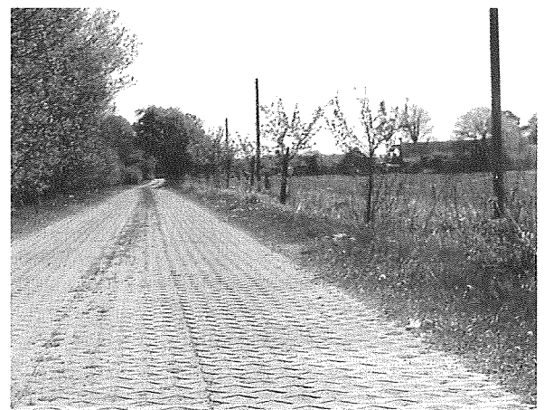
Abb. 5: Vollausbau mit Rasengittersteinen
