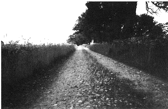
Abb. 1b: Sandgeschlämmte Sammelsteintragschicht mit Randbefestigung aus Betonbahnschwellen; Bauphase und nach ca. 12 Jahren Nutzung
