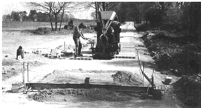
Abb. 10: Verlegung mit Pflastermaschine
