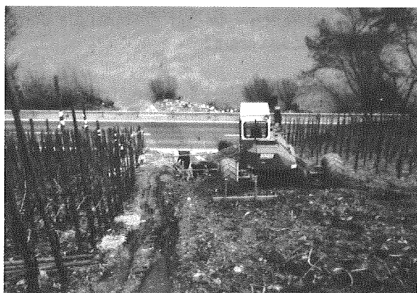
Abb. 12: Nachdem der Durchlaß durch die B 53 fertiggestellt war, konnte das Gewässer 410 mittels steilhangfähigen Schreitbagger bei 50% Hangneigung hergestellt werden.
