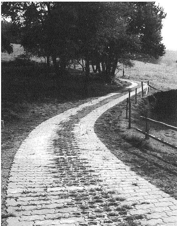
Abb. 5: Weg mit einer Kombination von Verbundpflastersteinen und Rasenverbundsteinen zur teilweisen Begrünung bei Obersensbach, Odenwald (Foto: Hersel)
