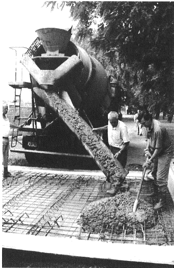
Abb. 10: Betonieren der Brückenplatte auf die endgültige Plattendicke
