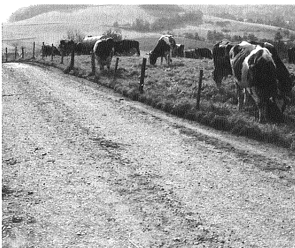
Abb. 1: Naturnaher Weg mit hydraulisch gebundener Tragdeckschicht (HGTD) in Gumpen, Odenwald; vom Rand aus und in der Mitte beginnt eine Begrünung der wenig beanspruchten Wegbereiche (Foto: Hersel)
