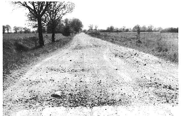
Abb. 2: Wassergebundene Decke mit Schäden
