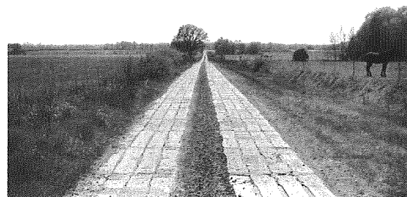
Abb. 4b: Spurbahnweg mit alten Betonbahnschwellen; Bauphase und nach 11 Jahren Nutzung
