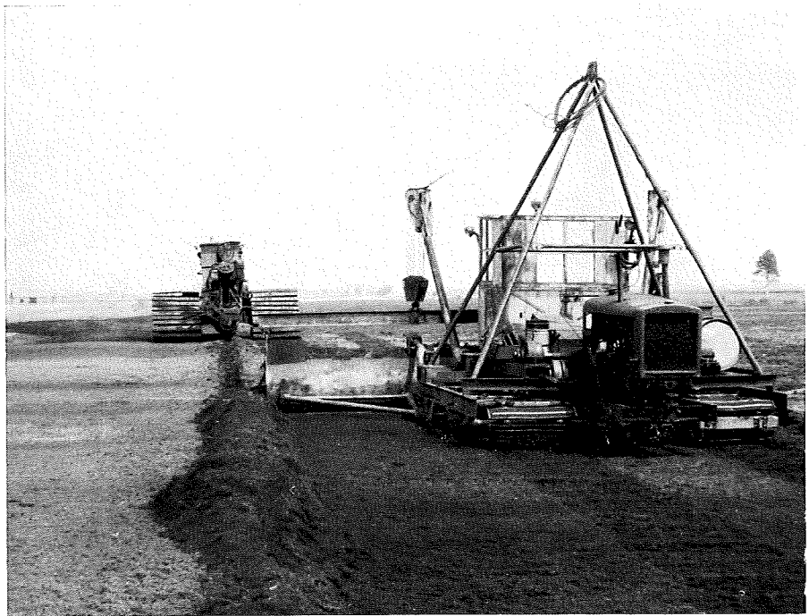
Abb. 11: Verfüllen der Schlitzte mit Planierschnecke (links bereits übersandete Fläche)
