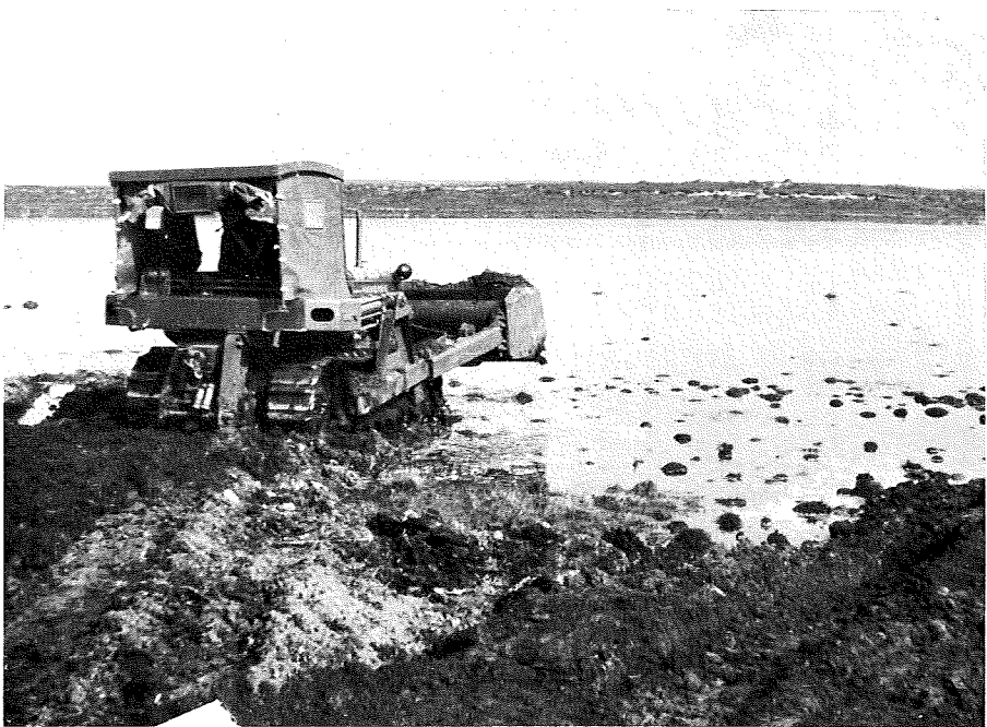
8: Die Steilkanten des Schlatts werden abgeflacht
