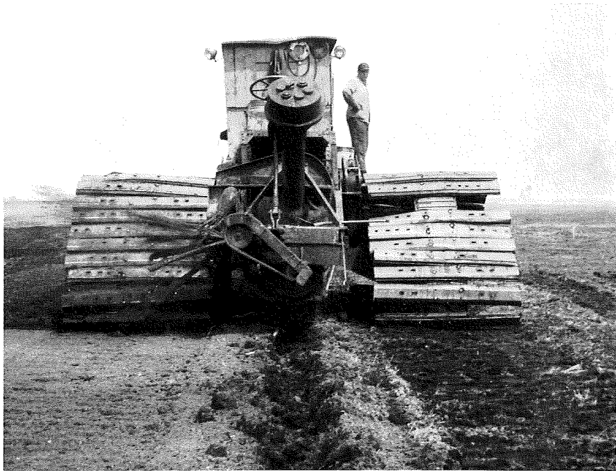
Abb. 9: Der Untergrundförderer der Fa. Rathjens
