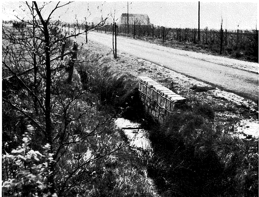
Abb. 16: Aus Natursteinen gemauerte Stirnwand am Wasserzug in der Siedlung
