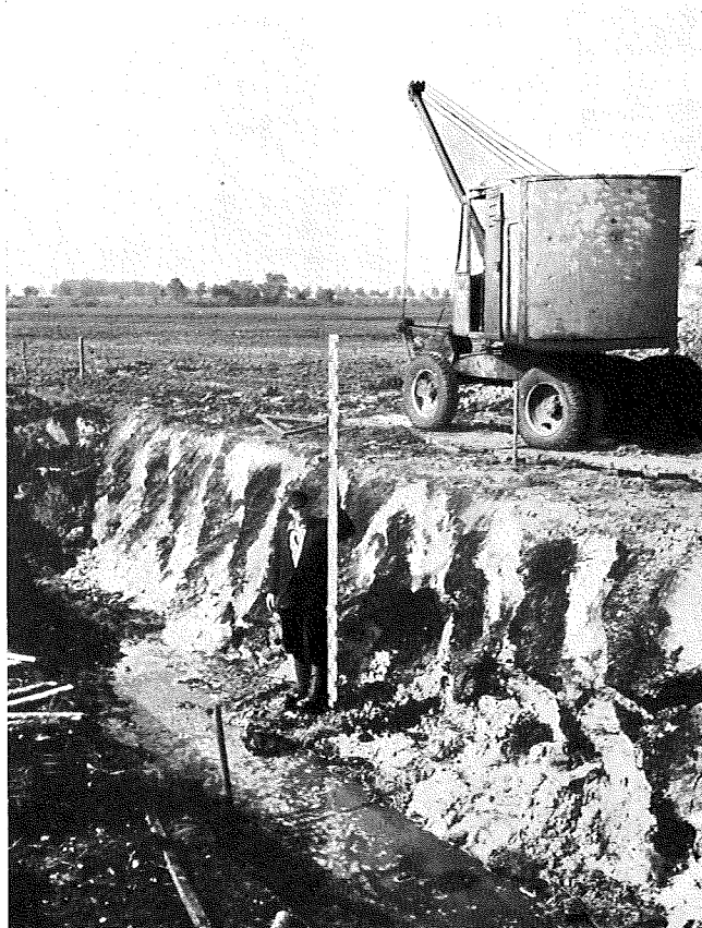
Abb. 6: Angeschnittenes Profil durch tiefgepflügte Flächen (abwechselnd Sand und Torfbalken)
