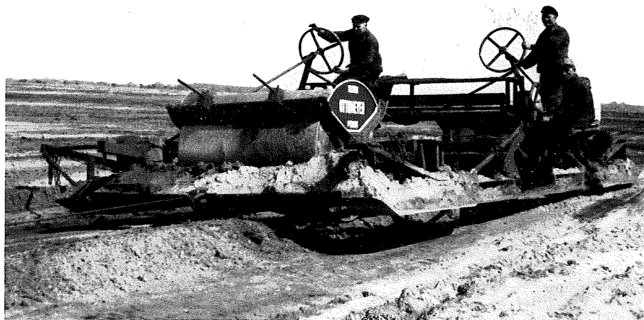
Abb. 7: Der Erdhobel glättet die Unebenheiten nach dem Pflügen
