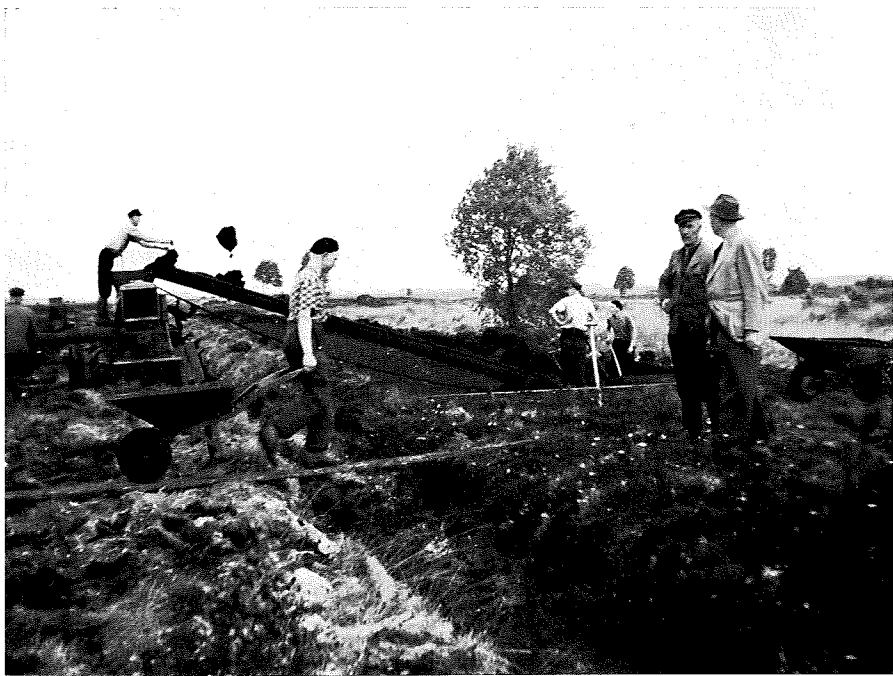
Abb. 21: Um Kosten für die Moorauskofterung zu sparen, wird der Wegekörper zur Torfgewinnung vergeben
