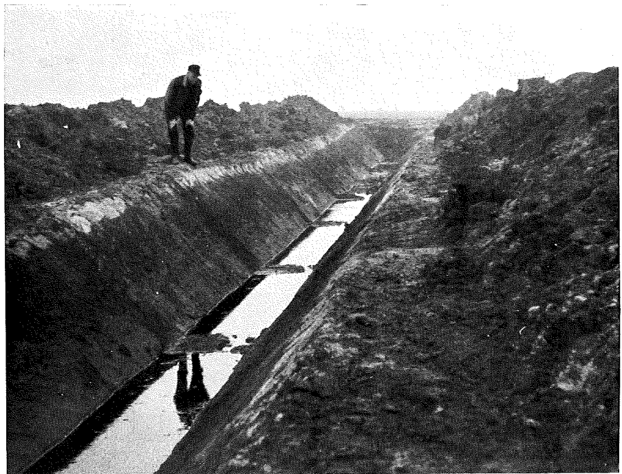
Abb. 12: Quer zu den gefahrenen Schlitzten angelegter Graben zeigt die Dränwirkung (vergl. Ausschlammung vor den Schlitzten)
