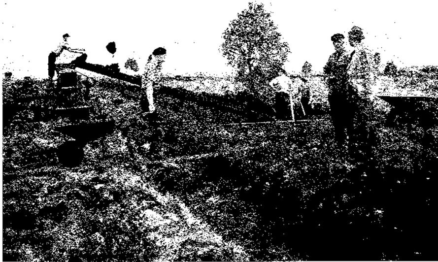
Abb. 21: Um Kosten für die Moorauskofterung zu sparen, wird der Wegkörper zur Torfgewinnung vergeben
