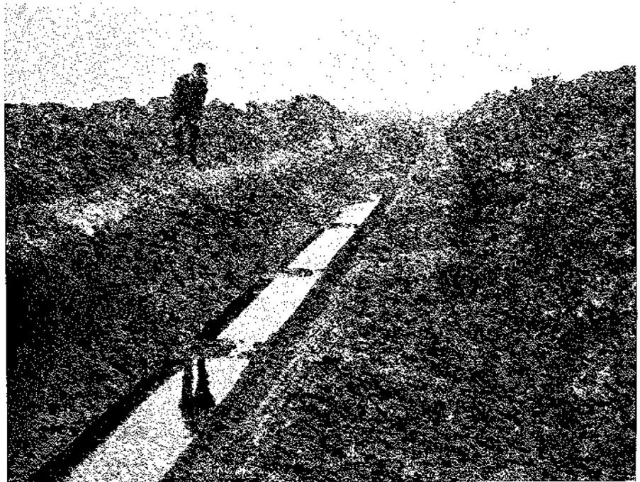
Abb. 12: Quer zu den gefahrenen Schlitzen angelegter Graben zeigt die Dränwirkung (vergl. Ausschlämzung vor den Schlitzen)
