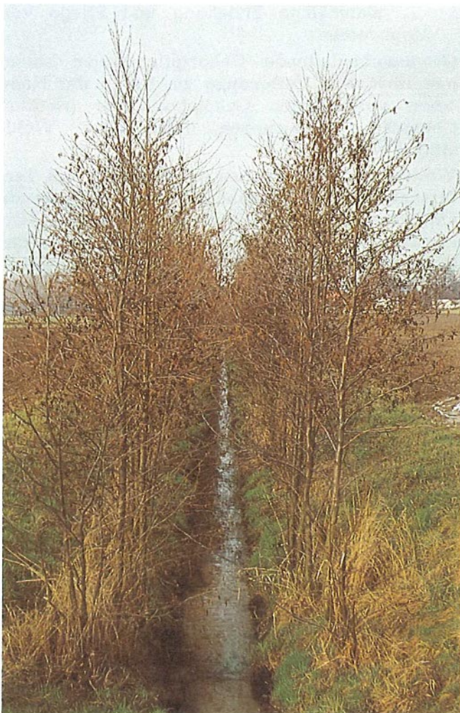
Der Bach 5 Jahre nach seiner streckenweisen Bepflanzung mit Schwarzerle ( Alnus glutinosa ). Die im unteren Böschungsdrittel in geschlossener Reihe angeordneten Gehölze unterdrücken infolge ihres sommerlichen Schattenwurfs störenden Aufwuchs im Hauptabflußbereich und stabilisieren das Gewässerbett. Sie bedürfen außer einer gelegentlichen Kontrolle auf lange Sicht keiner Pflege. Abb. Dr. A. Krause, BFANL.
