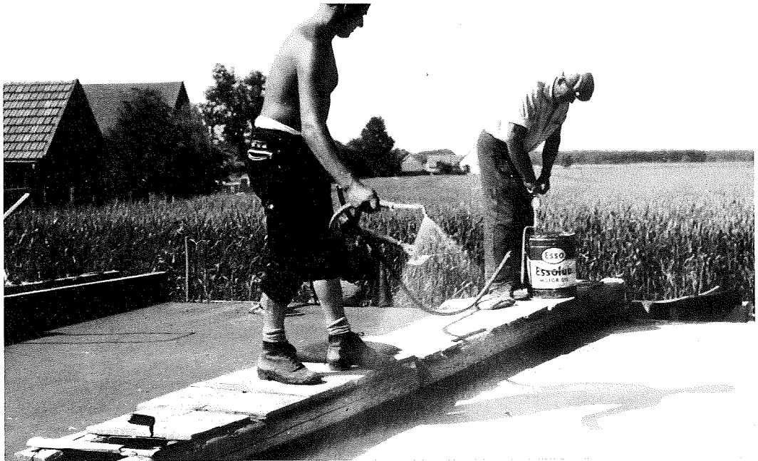
Bild 14: Aufsprühen des Nachbehandlungsfilmes (Hahn)
