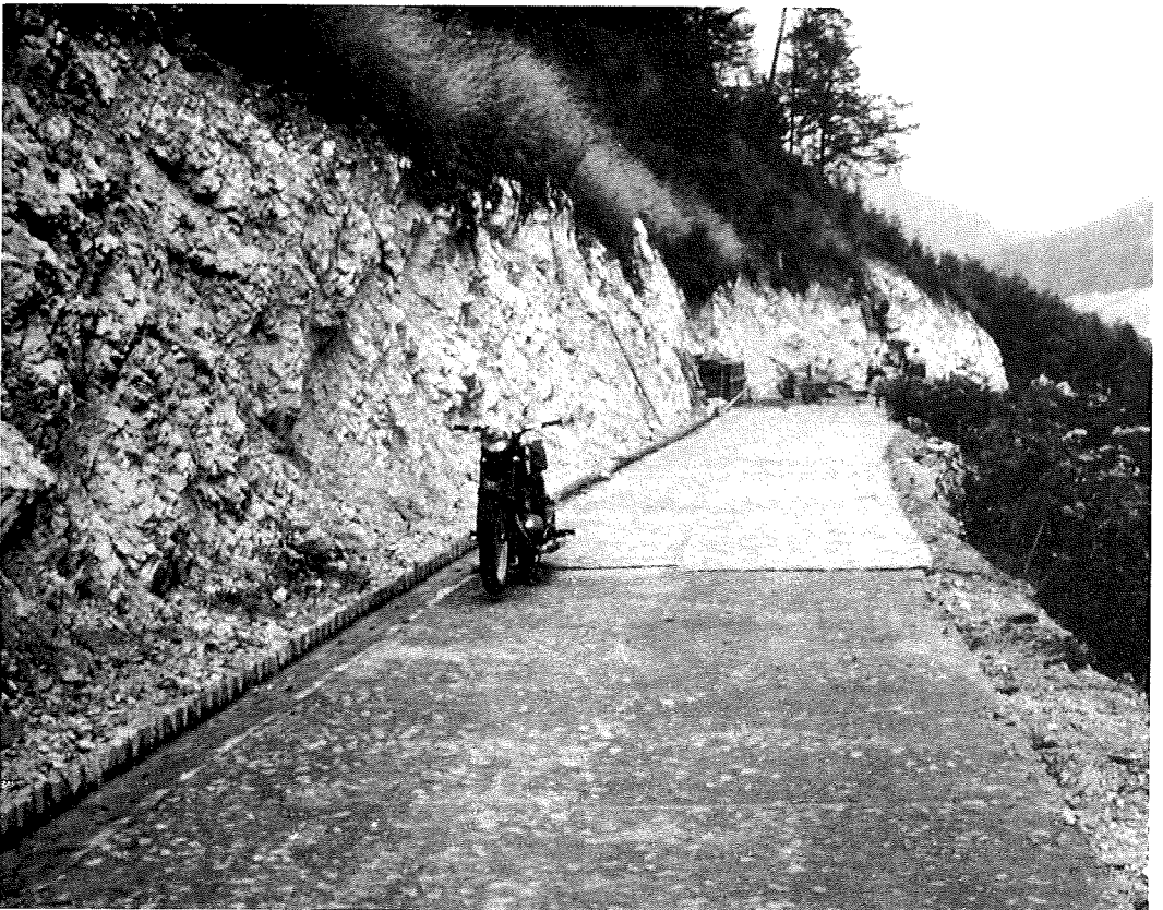
Bild 20: Rauhe Oberfläche eines Zementschotter-Weges im Gebirge (Burghard)
