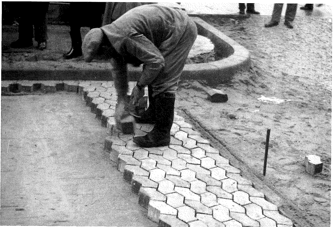
Bild 26: Verlegen von Betonpflastersteinen (ASG)
