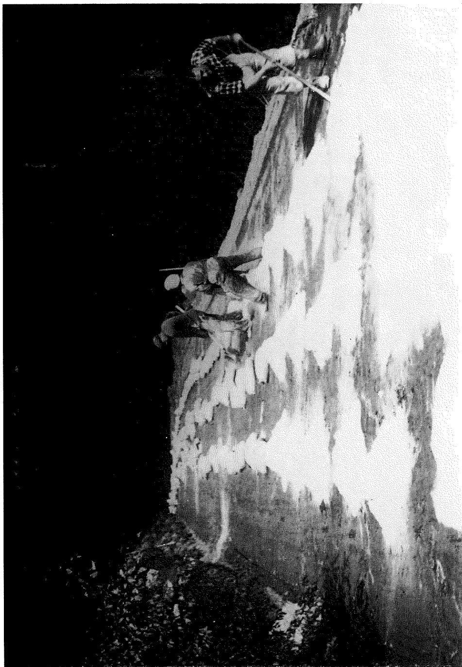
Bild 21: Verteilen des Zementes bei einer Bodenverfestigung
