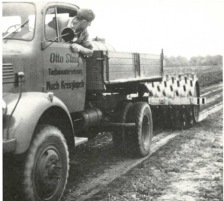
Bild 1: Schafffußwalze zum Verdichten bindiger Böden
