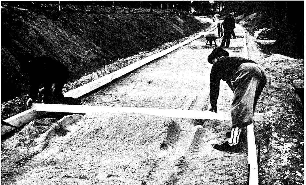
Bild 6: Höhenlage der Schalungshölzer wird überprüft (Burghard)
