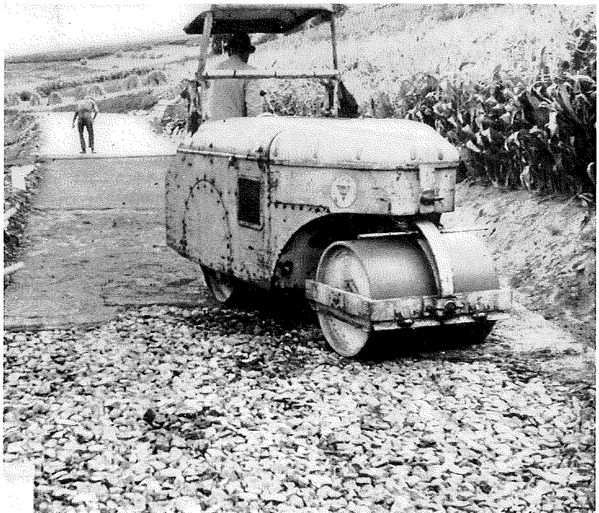
Bild 18: Rüttelwalze beim Bau einer Zementschotter- Decke (Burghard)
