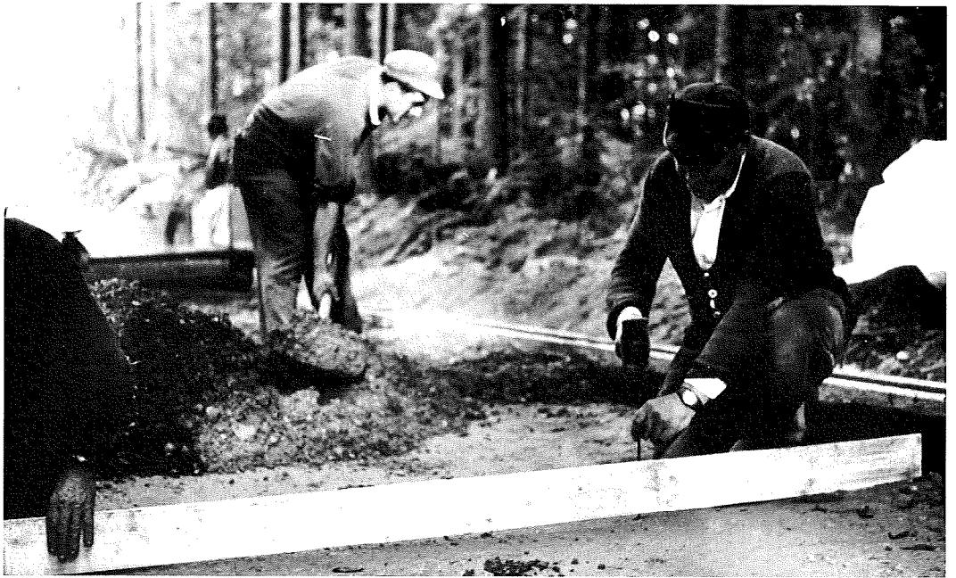
Bild 7: Befestigen der Fugenbretter (Burghard)
