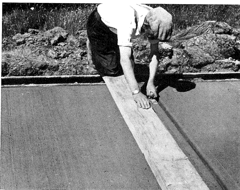
Bild 12: Nacharbeiten der Fuge (Hahn)
