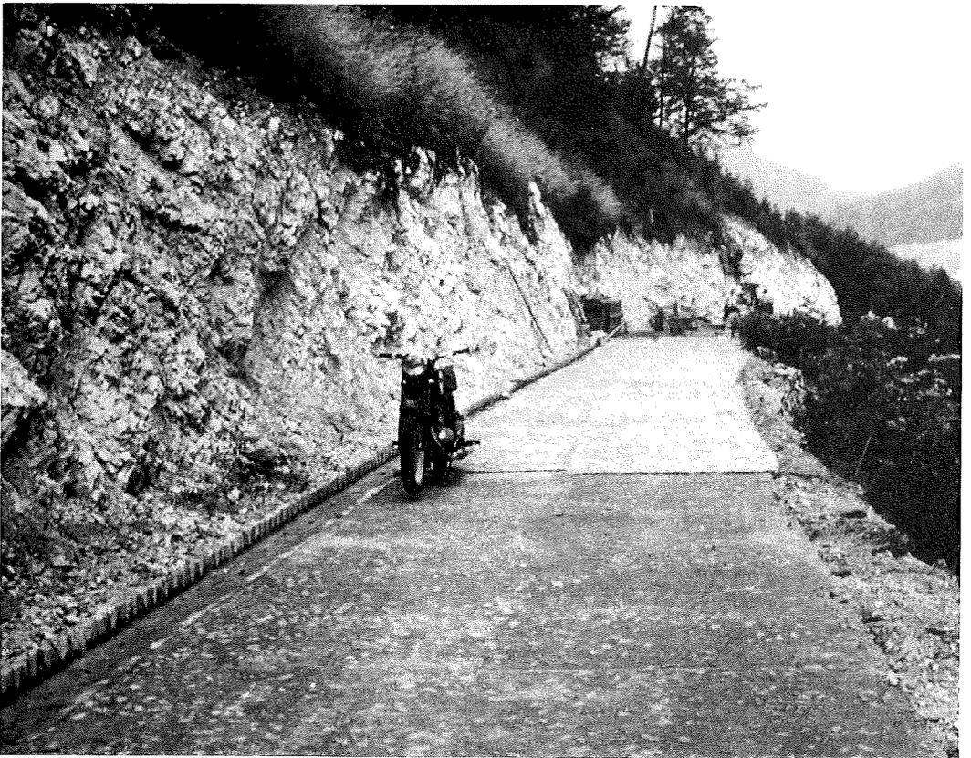
*Bild 20:* Rauhe Oberfläche eines Zementschotter-Weges im Gebirge (Burghard)
