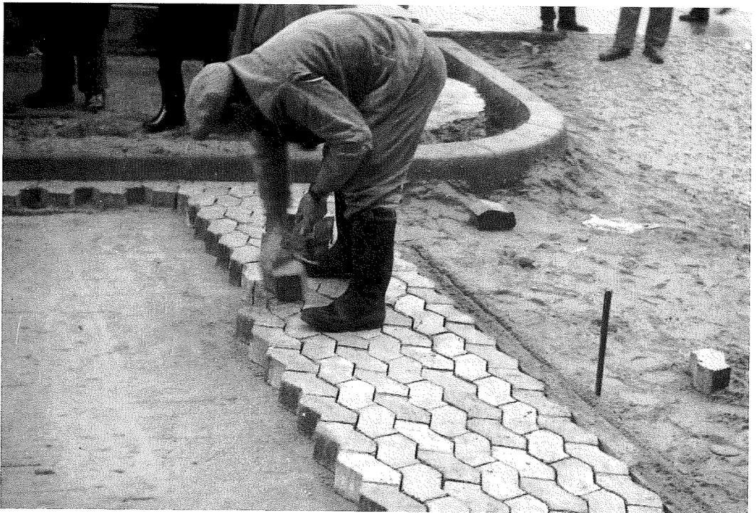
*Bild 26:* Verlegen von Betonpflastersteinen (ASG)
