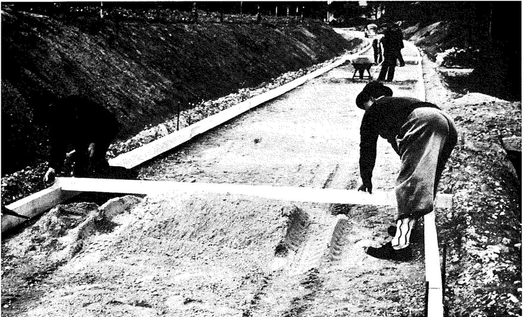
*Bild 6: Höhenlage der Schalungshölzer wird überprüft (Burghard)*
