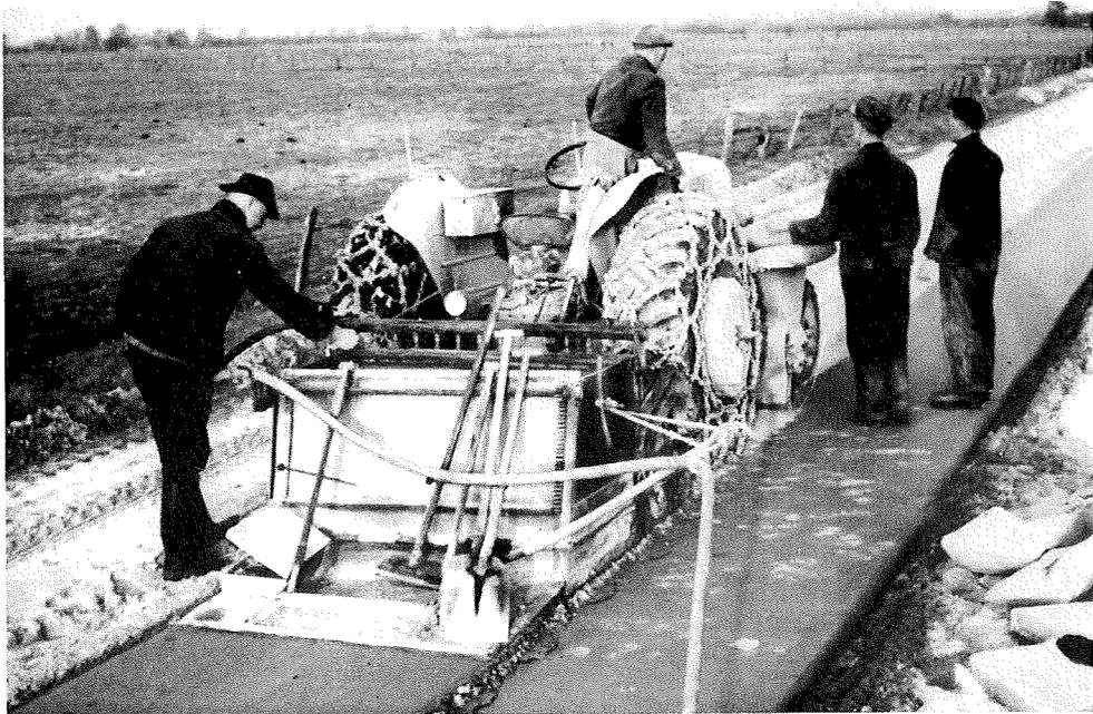
Bild 23: Eingang-Bodenmischmaschine
