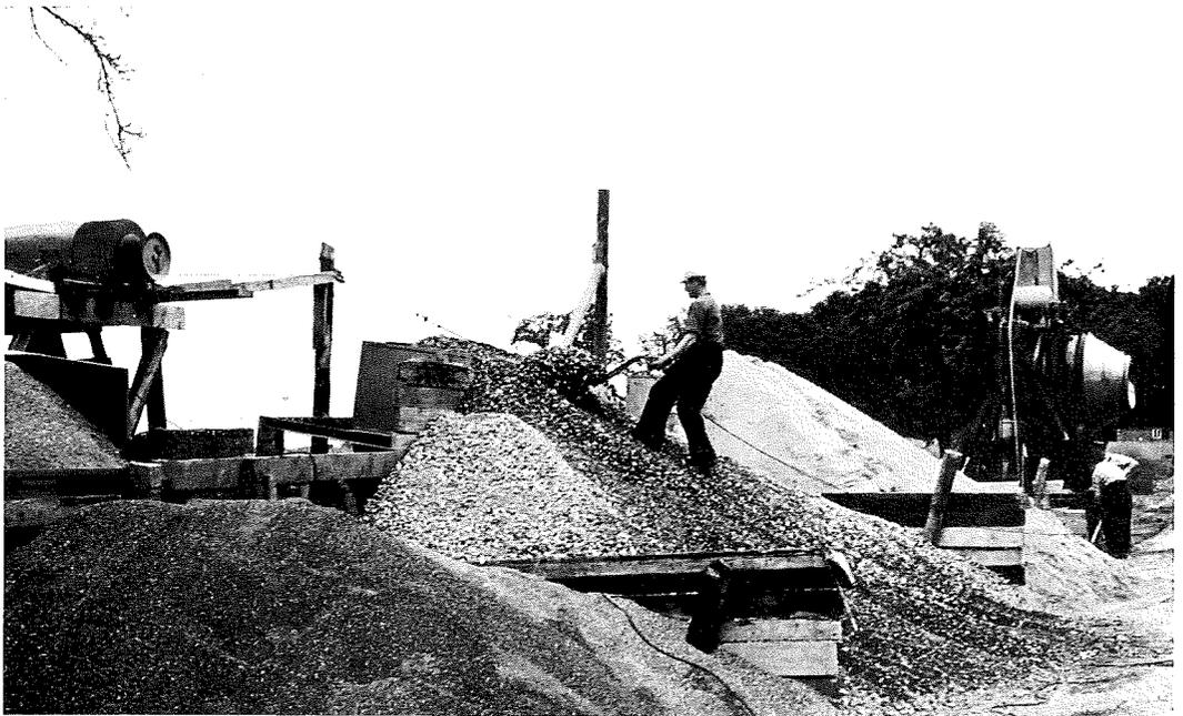
Bild 4: Lagerung der Betonzuschlagstoffe nach Korngruppen getrennt (Hahn)
