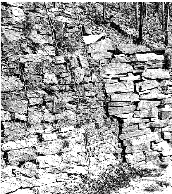
Abb. 7: Gabionen-Mauer mit Mäusepromenaden und Mauerpfusch
