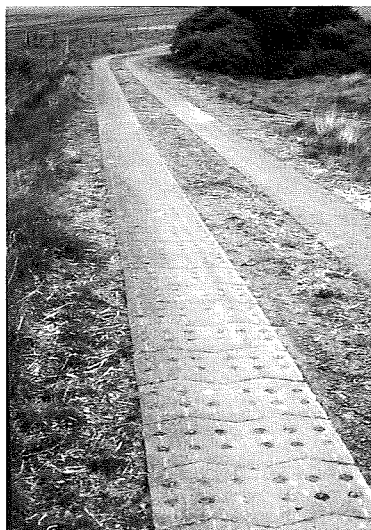
Betonsteinplatten als Spurbahn verlegt
