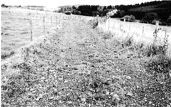
Eingebrachtes Recycling-Material
