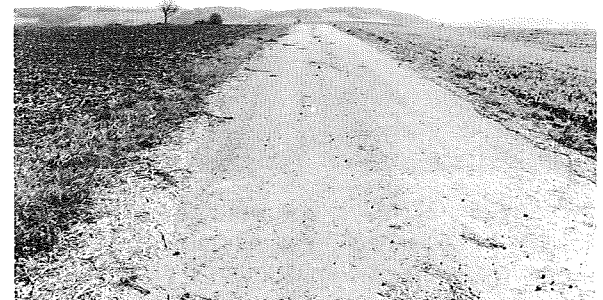
Vollflächige Versiegelung mit Bitumen
