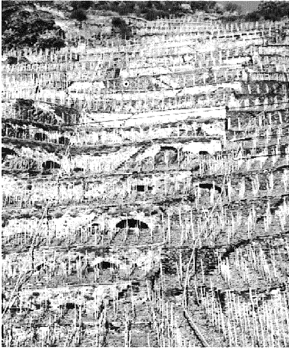
Abb. 3: Trockenmauern im Uhlen
