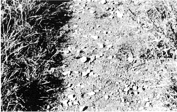
Fahrspur mit größeren Schotterkörnern
