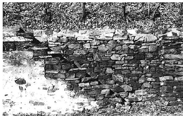
Abb. 8: Scherentreppe mit Schergang und Eckmauer
