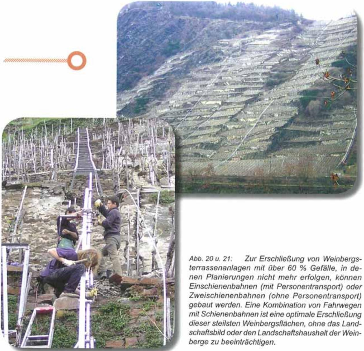
Abb. 20 u. 21: Zur Erschließung von Weinbergsterrassenanlagen mit über 60 % Gefälle, in denen Planierungen nicht mehr erfolgen, können Einschienenbahnen (mit Personentransport) oder Zweischienebahnen (ohne Personentransport) gebaut werden. Eine Kombination von Fahrwegen mit Schienenbahnen ist eine optimale Erschließung dieser steilsten Weinbergsflächen, ohne das Landschaftsbild oder den Landschaftshaushalt der Weinberge zu beeinträchtigen.
