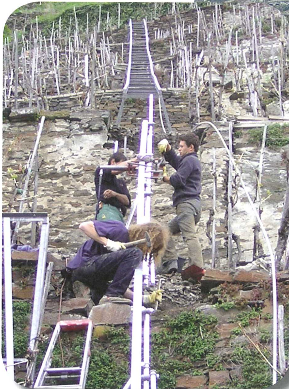
Abb. 20 u. 21: Zur Erschließung von Weinbergsterrassenanlagen mit über 60 % Gefälle, in denen Planierungen nicht mehr erfolgen, können Einschienenbahnen (mit Personentransport) oder Zweischielenbahnen (ohne Personentransport) gebaut werden. Eine Kombination von Fahrwegen mit Schienenbahnen ist eine optimale Erschließung dieser steilsten Weinbergsflächen, ohne das Landschaftsbild oder den Landschaftshaushalt der Weinberge zu beeinträchtigen.
