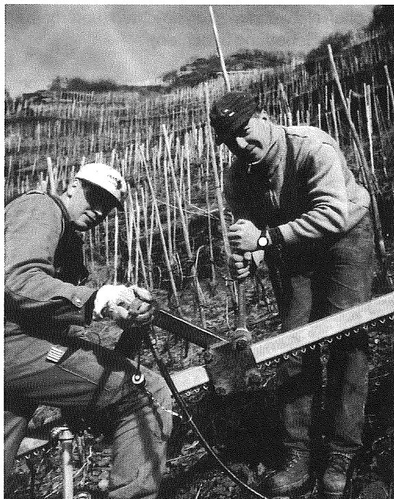
Abb. 3: Hier wird der Schienenstrang seitlich gebogen.
