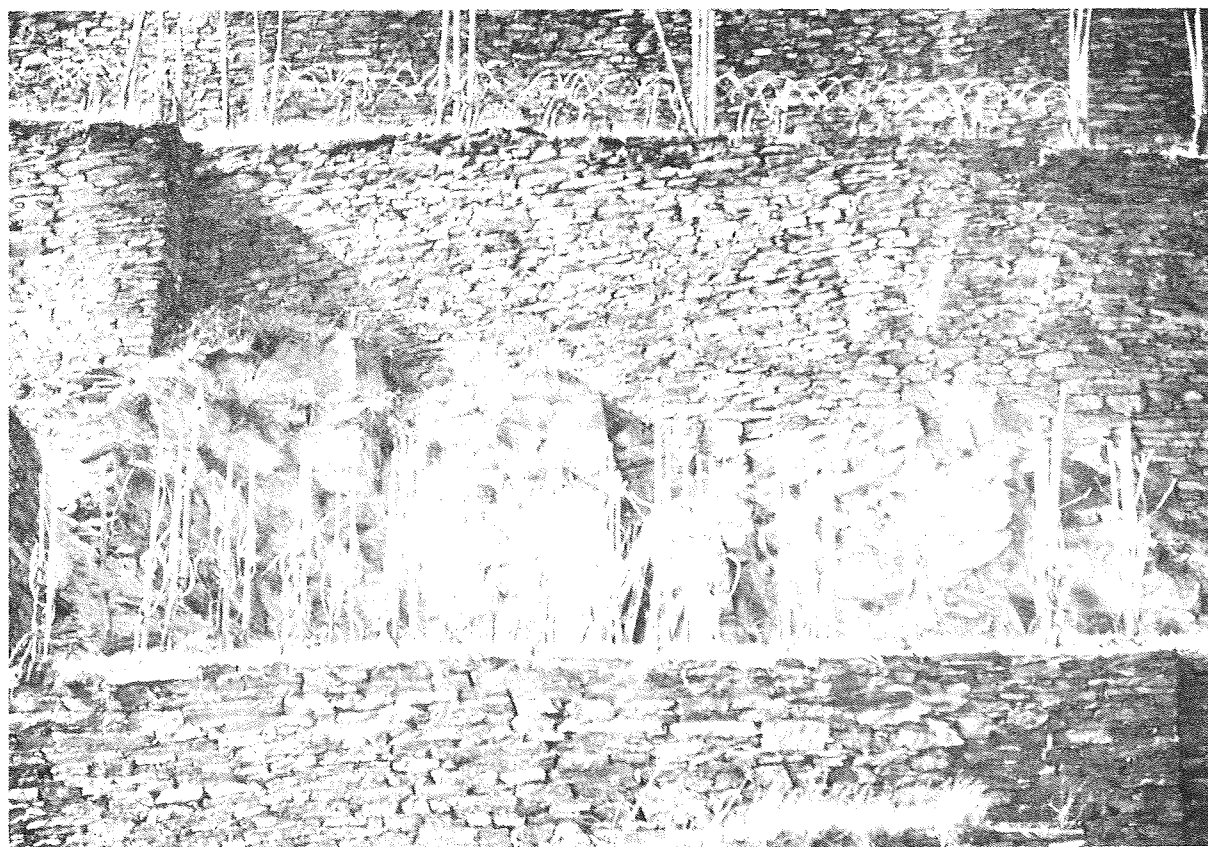
Bild 18: Trockenmauer auf Fels gegründet
