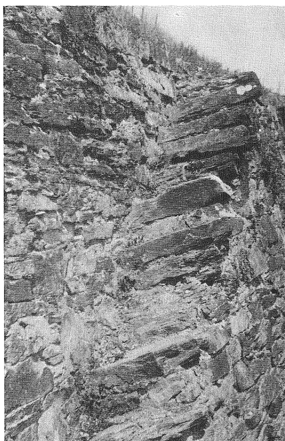
Bild 20: angesetzte Treppe mit bündiger Stufe
