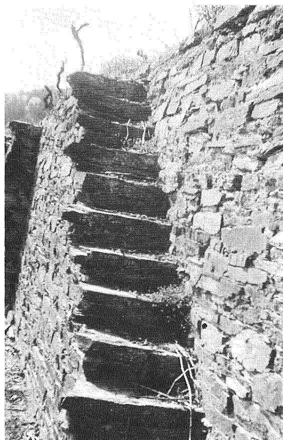
Bild 21: angesetzte Treppe mit überragender Stufe
