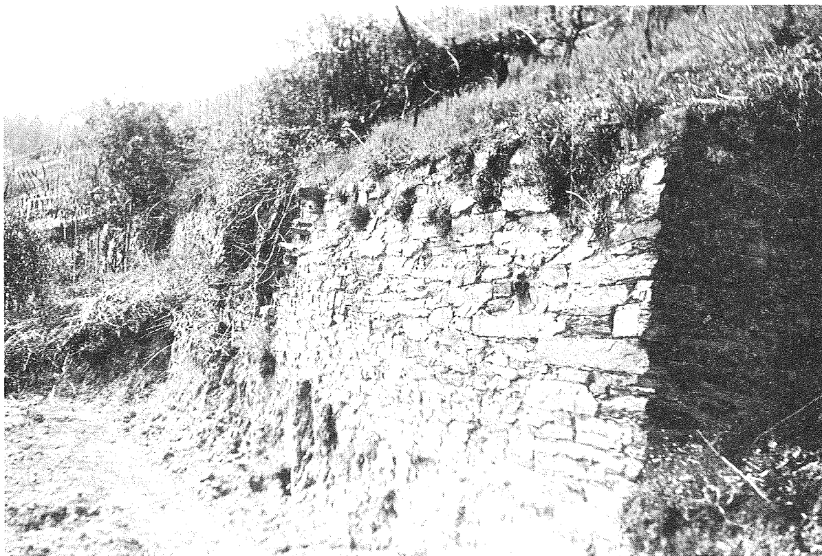
Bild 17: Trockenmauer im Erdreich gegründet
