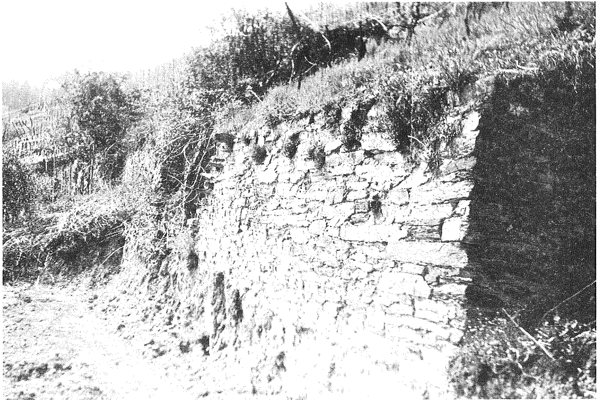
Bild 17: Trockenmauer im Erdreich gegründet
