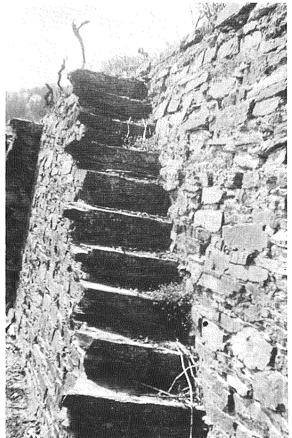
Bild 21: angesetzte Treppe mit überragender Stufe
