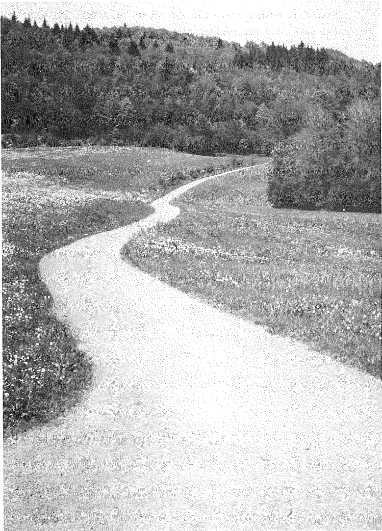
Bild 4 AOB-Wegebefestigung im Grünland mit guter Geländeanpassung; weitgehend fließender Übergang von Fahrbahn zum Gelände (Ältere AOB-Strecke in Germannsdorf, Weg Nr. 58)
