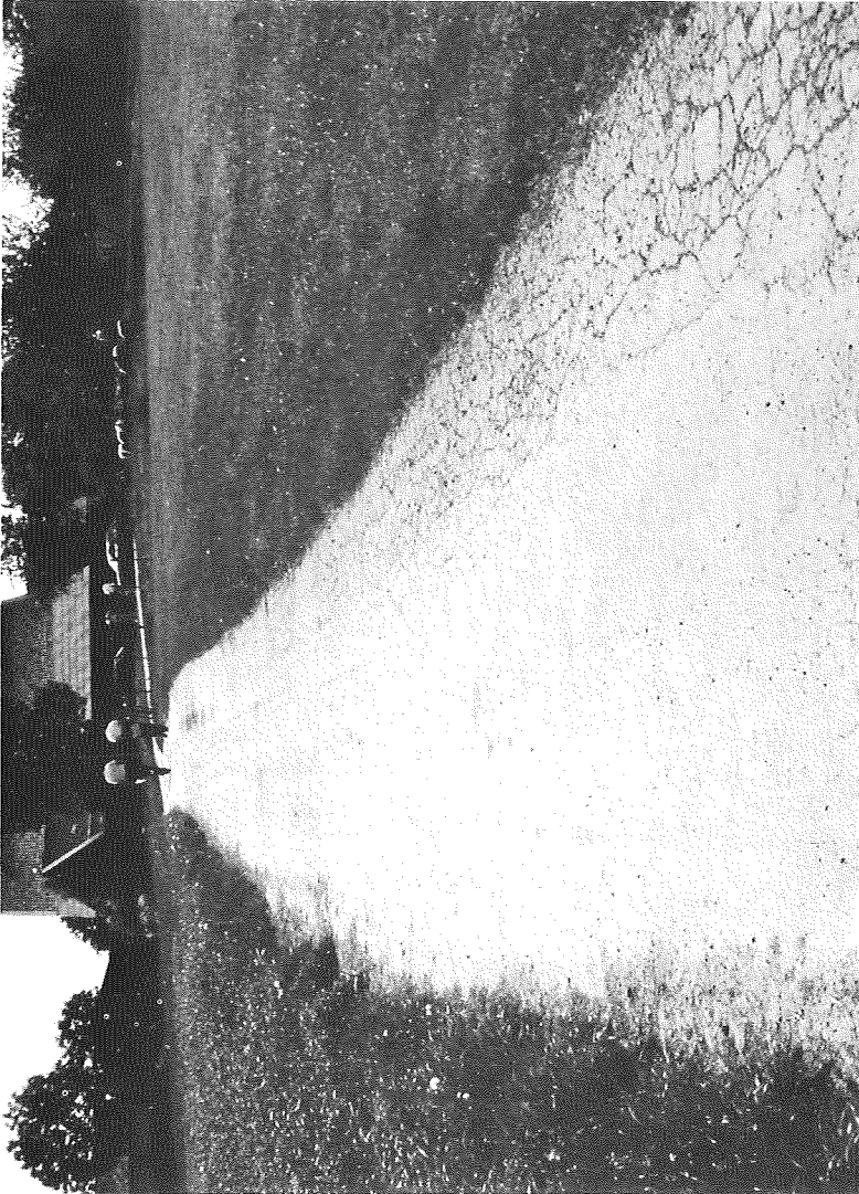
Bild 10 Sehr geringe Schicht, 120 \text{ kg/m}^2 \approx 5 \text{ cm} bei 9 Jahre alter AOB-Strecke (Windpassing, Weg Nr. 73)
