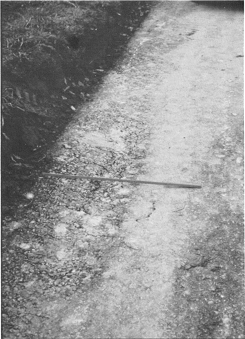
Bild 2 AOB-Wegebefestigung tiefer liegend als die Gelände- oberfläche mit Fahrbahnschaden infolge Schichtwasser (Versuchsstrecke Nr. 116 025 in Aicha v.Wald)
