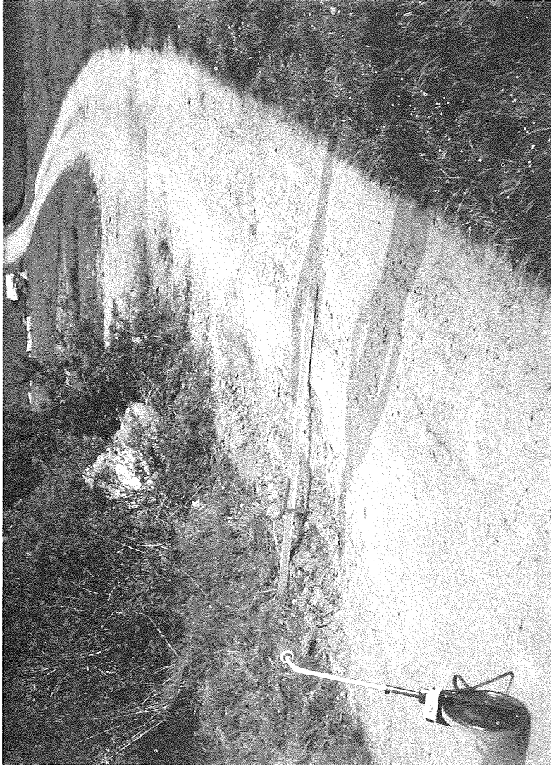
Bild 9 Fahrbahnschaden (Schadensstufe IV) infolge Überbelastung durch nachträglichen Baustellenverkehr (Versuchsstrecke Zinzenzell, Weg Nr.28)
