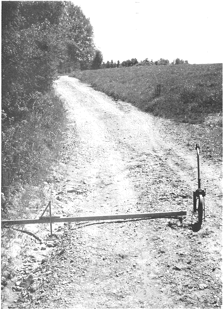
Bild 11 Fahrbahnschaden bei Vergleichsstrecke infolge Wassererosion bei einem Gefälle von etwa 10 % (Strecke Nr. 117 285 in Aicha v.Wald)
