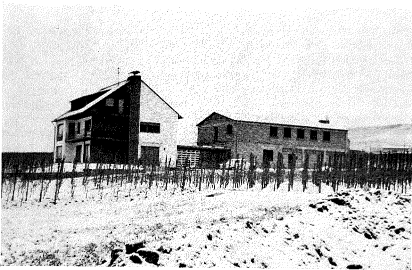
Abbildung 3: Ein Aussiedler in Kröv baut Fremdenzimmer aus
