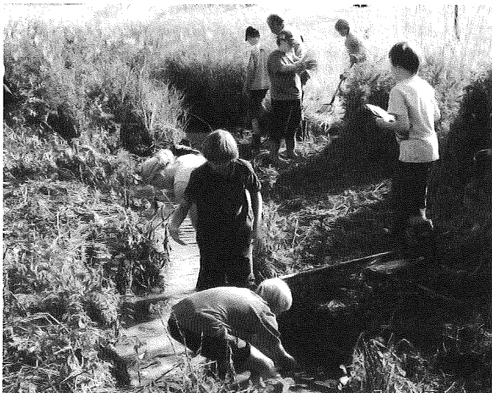
Abb.1: Schüler des GSG Daun entfernen mit vereinten Kräften die Sohlstickung am Tiefenbach
