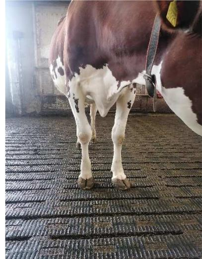
Abbildung 3: Perforierter Boden mit Profil und Dichtungsklappen (Foto: DLR Eifel/ Wolter)
