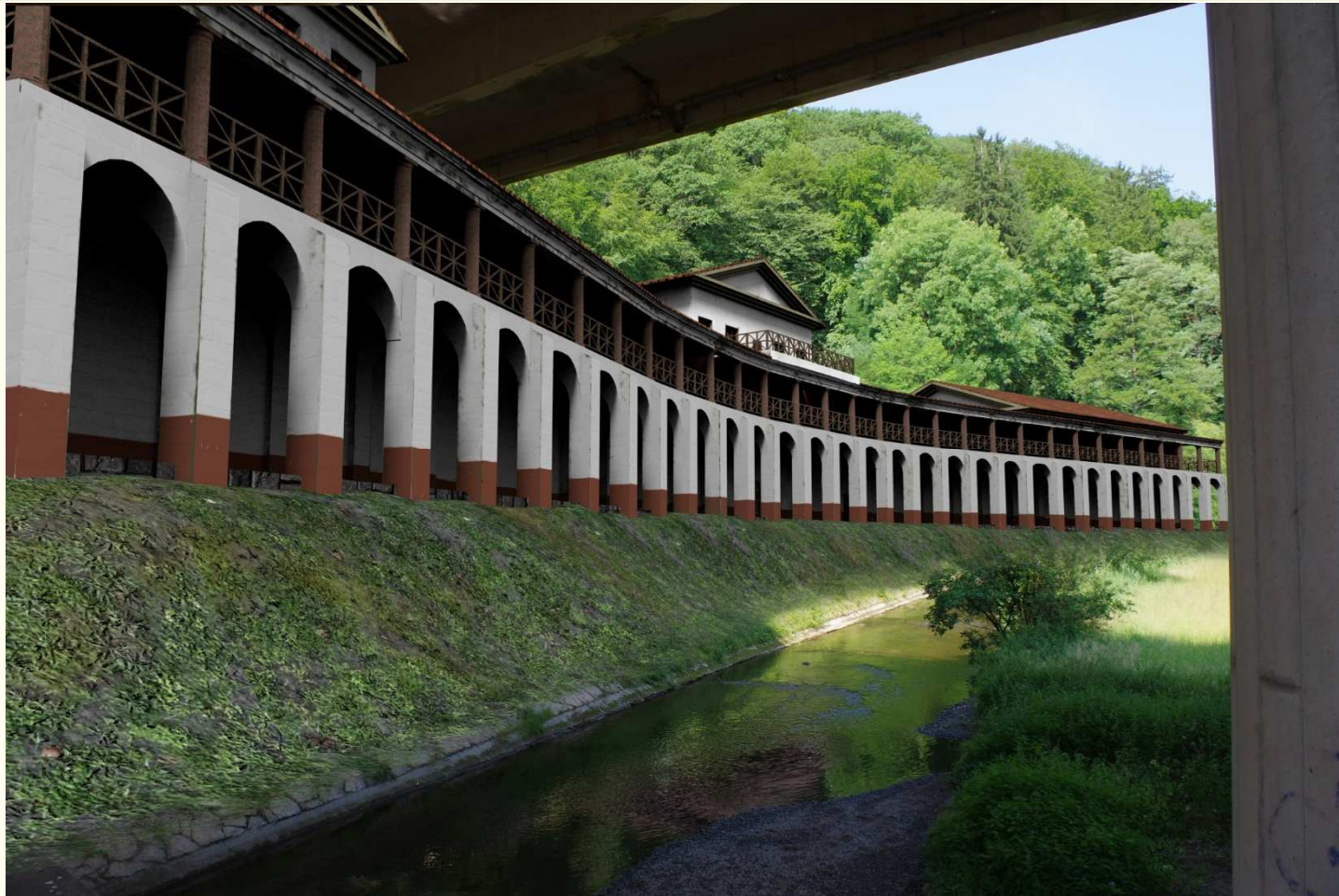
Villa Wittlich (und die Autobahn)
