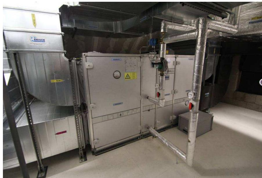
Einbau einer Wärmerückgewinnung sowie einer Luftqualitätsregelung (CO<sub>2</sub>)
