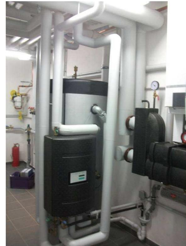
Quelle: Büro Koller, Frischwasserstationen in einer Turnhalle sowie Kita
