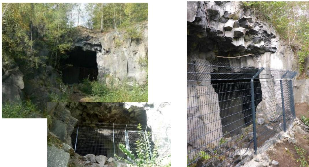
**Abbildung 31: Ursprünglicher Zustand eines Stolleneingangs (links oben) sowie nach Vergitterung (links unten); Vergitterung eines weiteren Stolleneingangs (rechts).**
