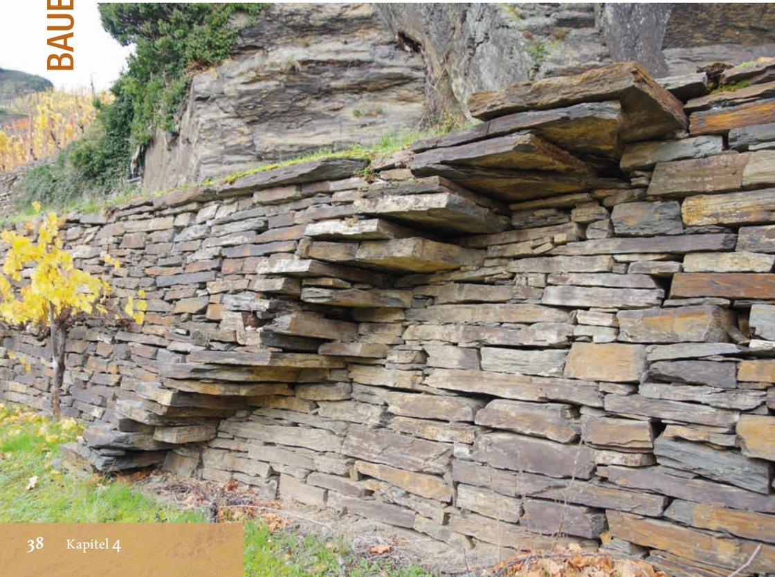
Die Trockenmauer wird, wenn sie Funktionen als Stützmauer übernehmen soll, wie eine Schwergewichtsmauer dimensioniert. Die Lasten, die auf eine Mauer einwirken, sind zum einen die aktive Erddruckkraft des Bodens sowie ggf. weitere Auflasten, zum Beispiel zusätzliche Belastung durch Maschinen. Bei freistehenden Mauern sind insbesondere die Windlasten zu berücksichtigen.
