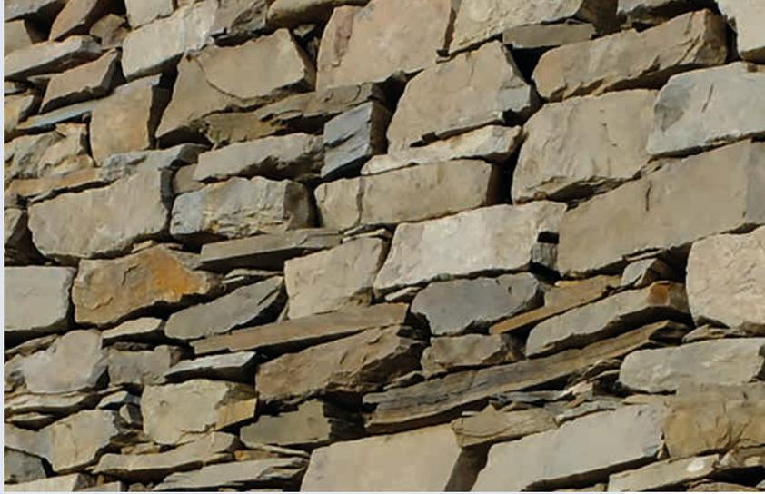
Abbildung 6: Trockenmauer aus Grauwacke
