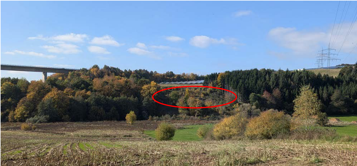
Das Verfahrensgebiet des Vereinfachten Flurbereinigungsverfahrens Weinsfeld (Hanggrutsch) umfasst ca. 35 ha. Unterhalb der Photovoltaikanlage ist der Hanggrutsch zu erkennen. © DLR Eifel
