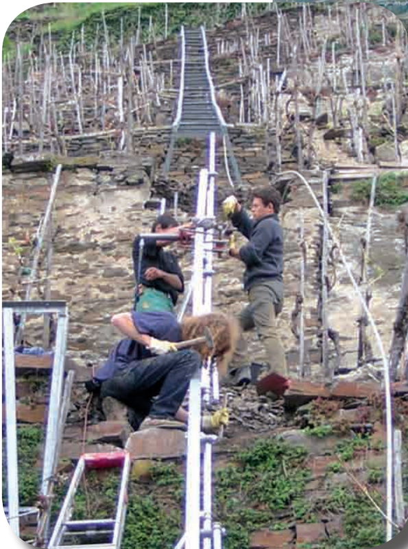
Abb. 20 u. 21: Zur Erschließung von Weinbergsterrassenanlagen mit über 60 % Gefälle, in denen Planierungen nicht mehr erfolgen, können Einschienenbahnen (mit Personentransport) oder Zweischienenbahnen (ohne Personentransport) gebaut werden. Eine Kombination von Fahrwegen mit Schienenbahnen ist eine optimale Erschließung dieser steilsten Weinbergflächen, ohne das Landschaftsbild oder den Landschaftshaushalt der Weinberge zu beeinträchtigen.
